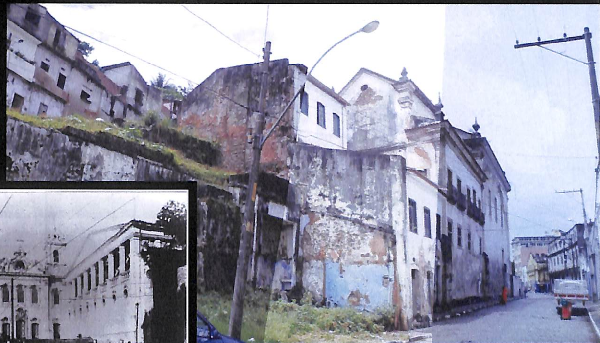
Fachada posterior da Igreja
