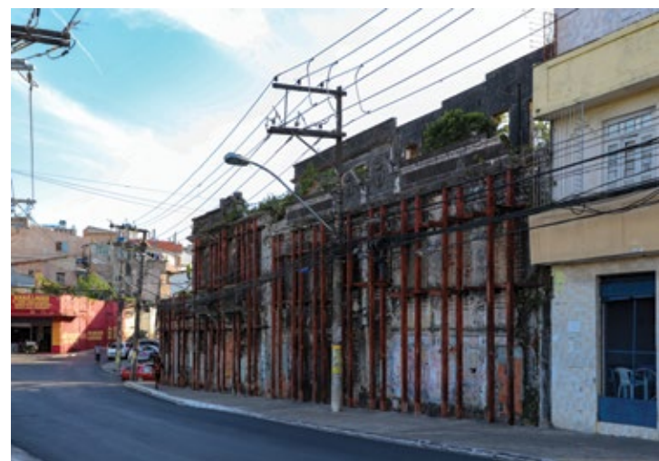
Imóvel com escoramento na Ladeira da Soledade. Fotografia: Paul R. Burley, 2018
