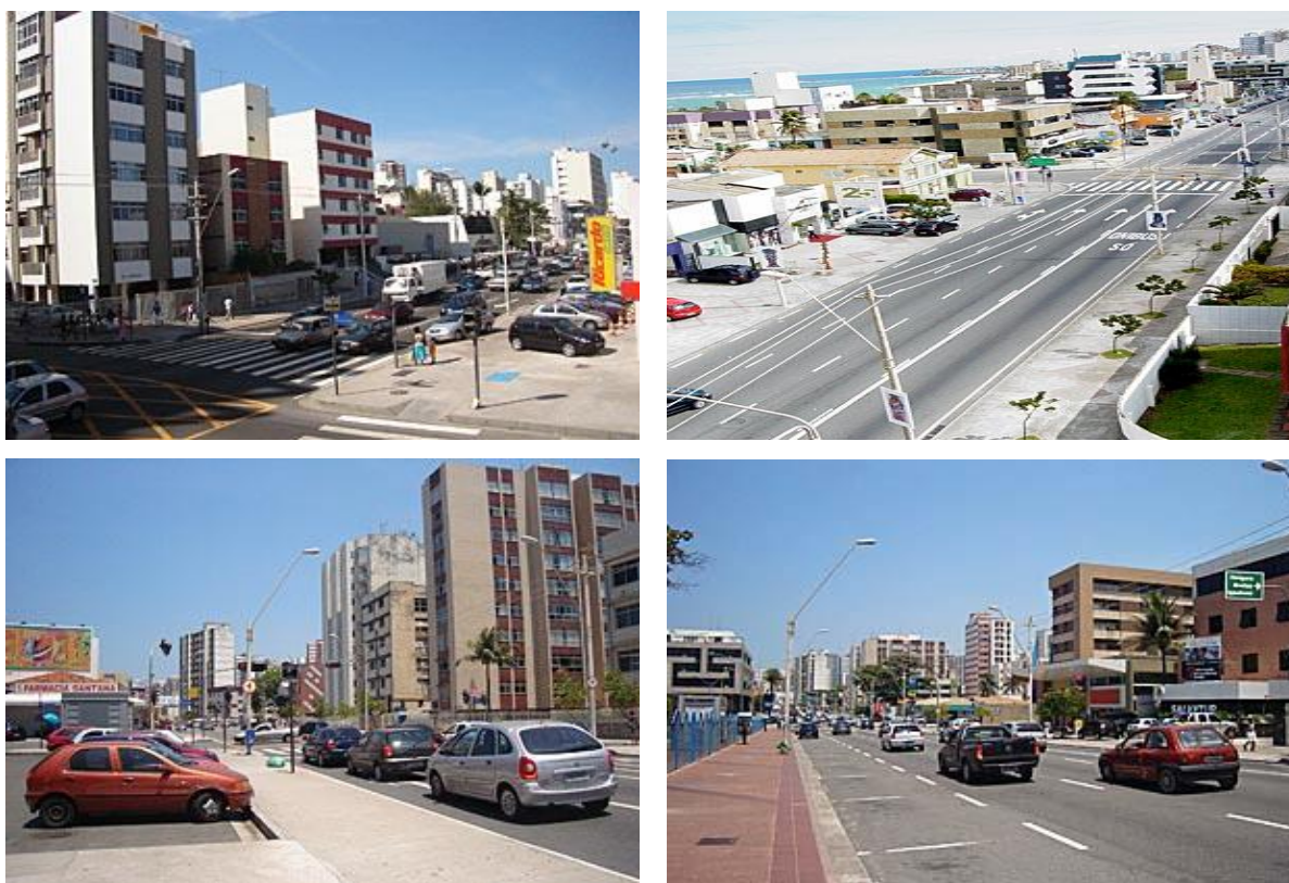
FIGURA 45, 46, 47 e 48 - Avenida Manoel Dias da Silva – Após obras de qualificação.
