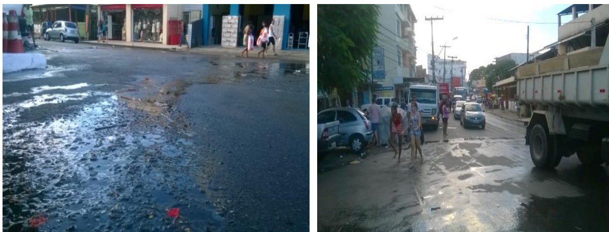
FIGURA 88 e 89- Vazamento de esgoto na principal avenida do bairro causa transtorno aos moradores e transeuntes.
