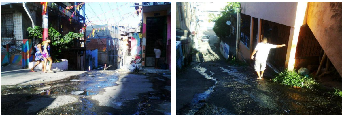
FIGURA 49 e 50 – Esgotos escorrendo livremente pelas ruas da Liberdade
