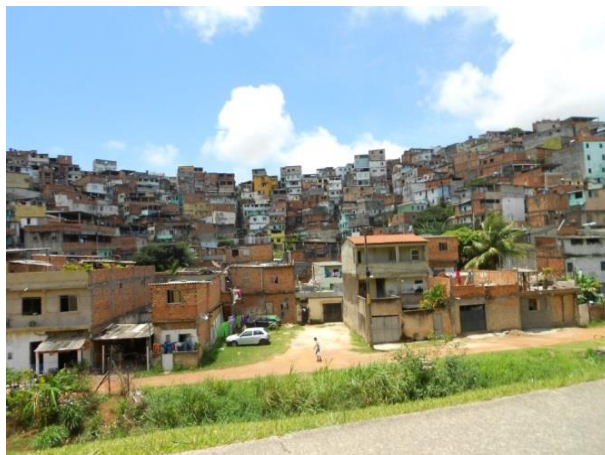
FIGURA 85 - Rua sem recapeamento asfáltico (Boa Vista de São Caetano)
