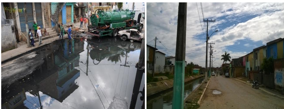
FIGURA 73 e 74 - Esgotos tomam a Rua Regis Pacheco e a Rua do Canal/Bela Vista – Bairro do Uruguai
