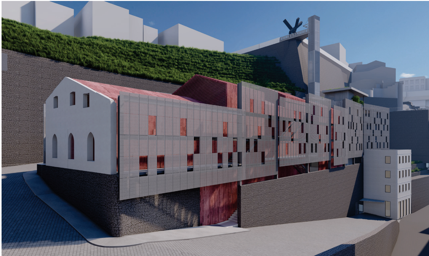
Figura 47 - Vista das fachadas Noroeste e Nordeste (parede remanescente).
