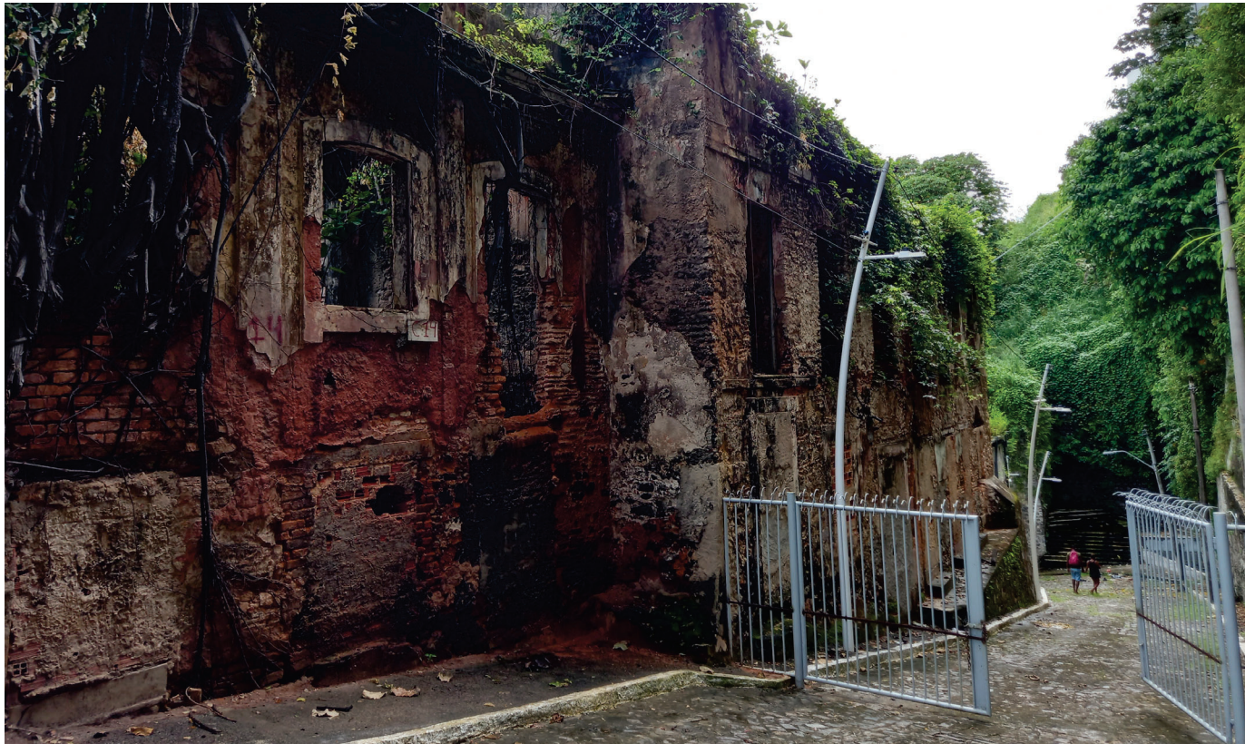
Figura 41 - Registro do conjunto de ruínas (imóveis nº12, nº14 e nº16) antes do desmoronamento/demolição.
