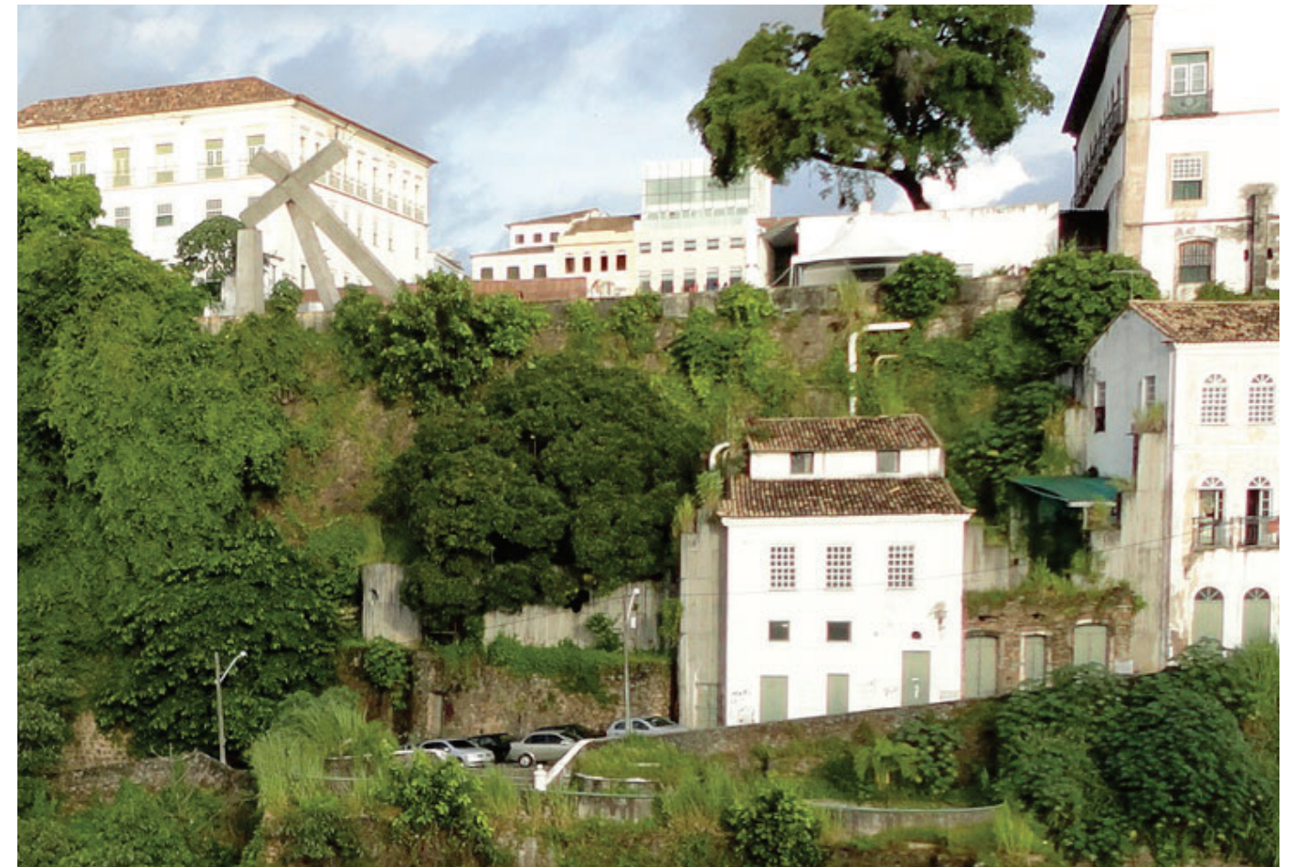
Figura 39 – Vista frontal do conjunto de imóveis nº5, nº7 e Restaurante Coati, ao fundo Praça da Cruz Caída.
