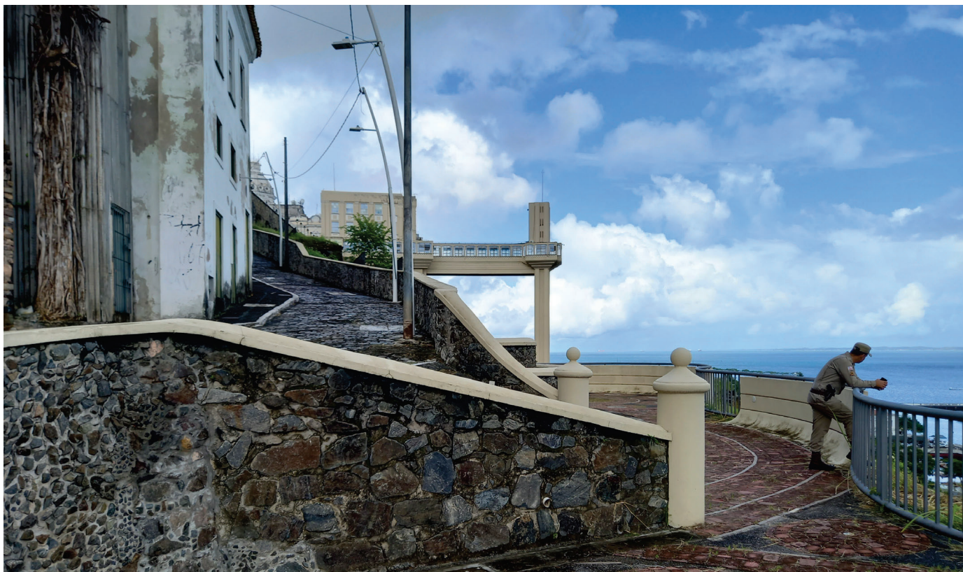
Figura 05 – Vista mirante existente defronte ao Coati evidencia a falta de acessibilidade universal ao espaço público.
