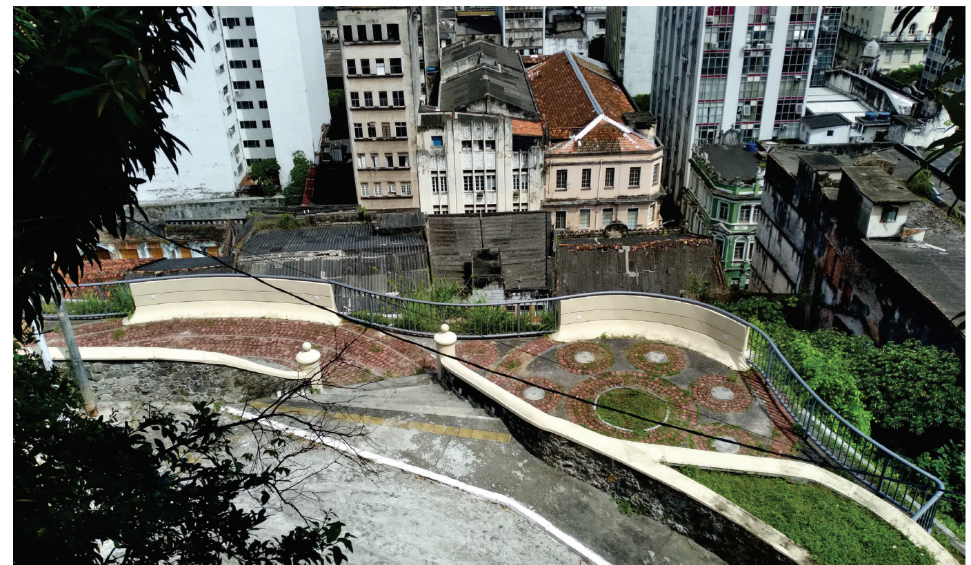
Figura 03 – Vista aérea do mirante existente defronte ao Coati evidencia a falta de acessibilidade universal ao espaço público.
