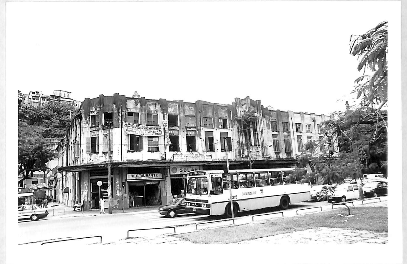
Foto 40 - Vista da fachada principal do Mercado do Ouro.
