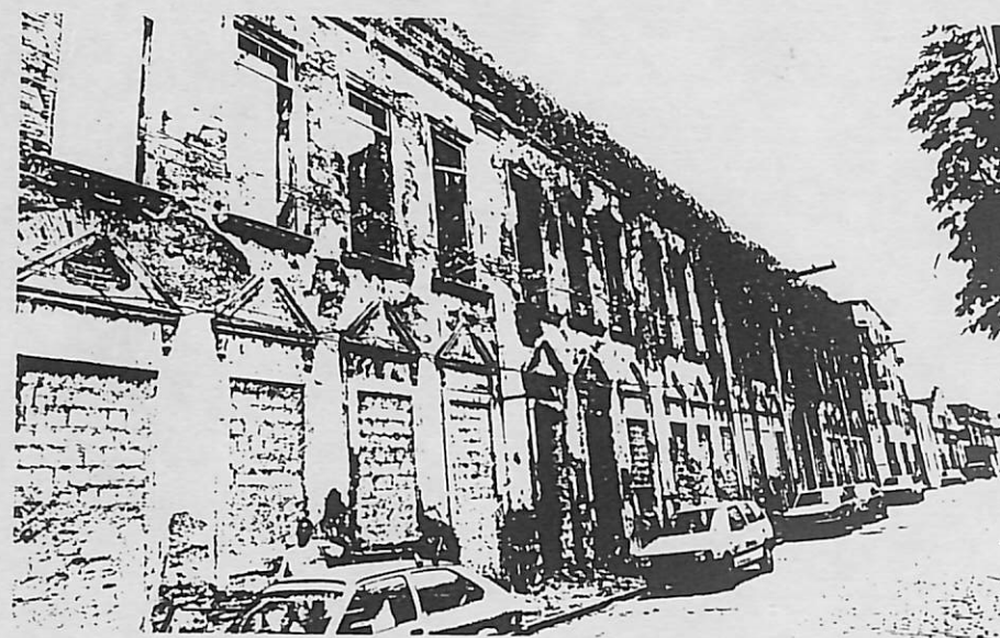
Foto 10 - Vista da fachada posterior do Trapiche Barnabé.
