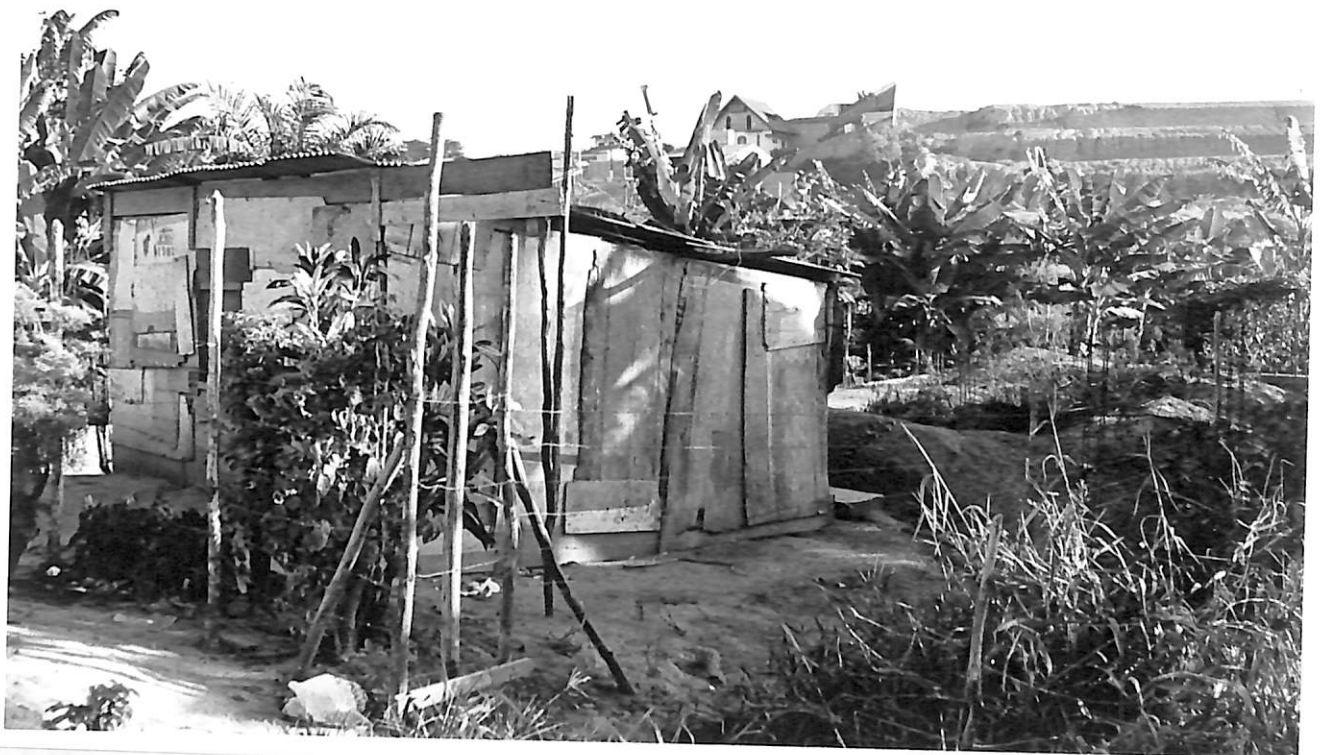
Barracos de madeira
