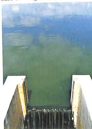
Lagoa de Tratamento de Esgotos Conjunto Ceará, Fortaleza, CE
