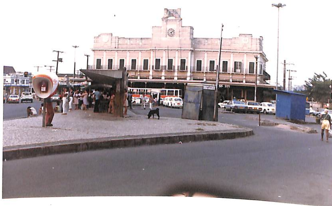
Estação Ferroviária da Calçada
