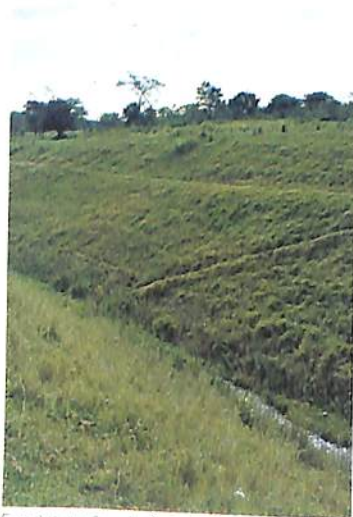
Estabilização de Fundo de Vale Parandity PR
