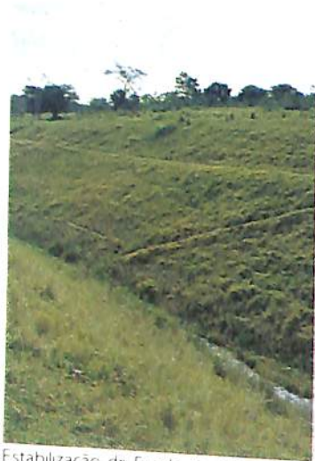
Estabilização de Fundo de Vale Paranacity, PR
