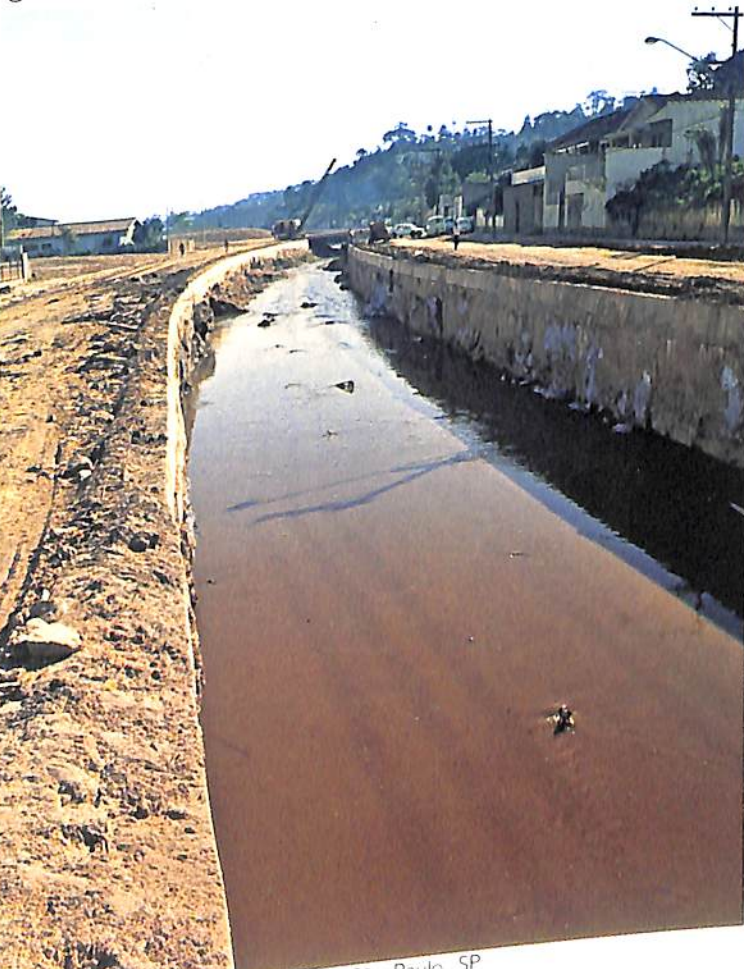
Canalização do córrego Pirajussara - São Paulo, SP
