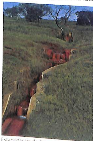
Estabilização de Encosta Parandity PR
