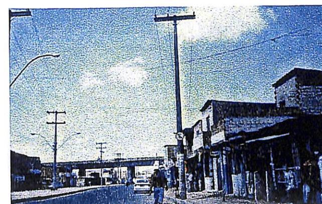
Av. Suburbana X Vd. dos Motoristas
