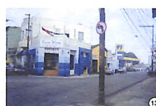
R. das Pitangueiras, próximo à futura Estação
