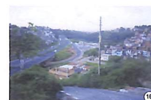
BR-324 e local da futura Estação Bom Juá do metrô,
