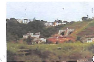
Vista dos túneis da Av. Luiz Eduardo Magalhães
