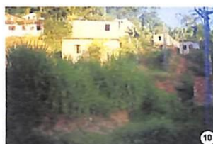
Local próximo à futura Estação Bom Juá do metrô,
