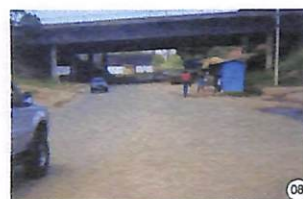
Passagem sob a BR-324,
