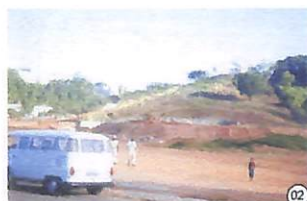
Local com as obras da Av.
