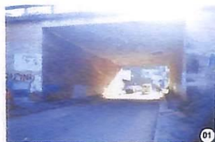
Passagem sob a BR-324,
