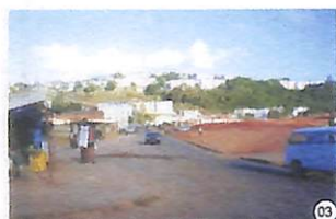
Local com as obras da Av.
