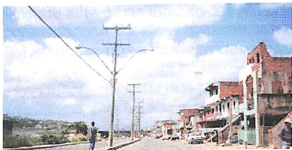
Av. Suburbana Trecho Vd. dos Motoristas / Lobato
