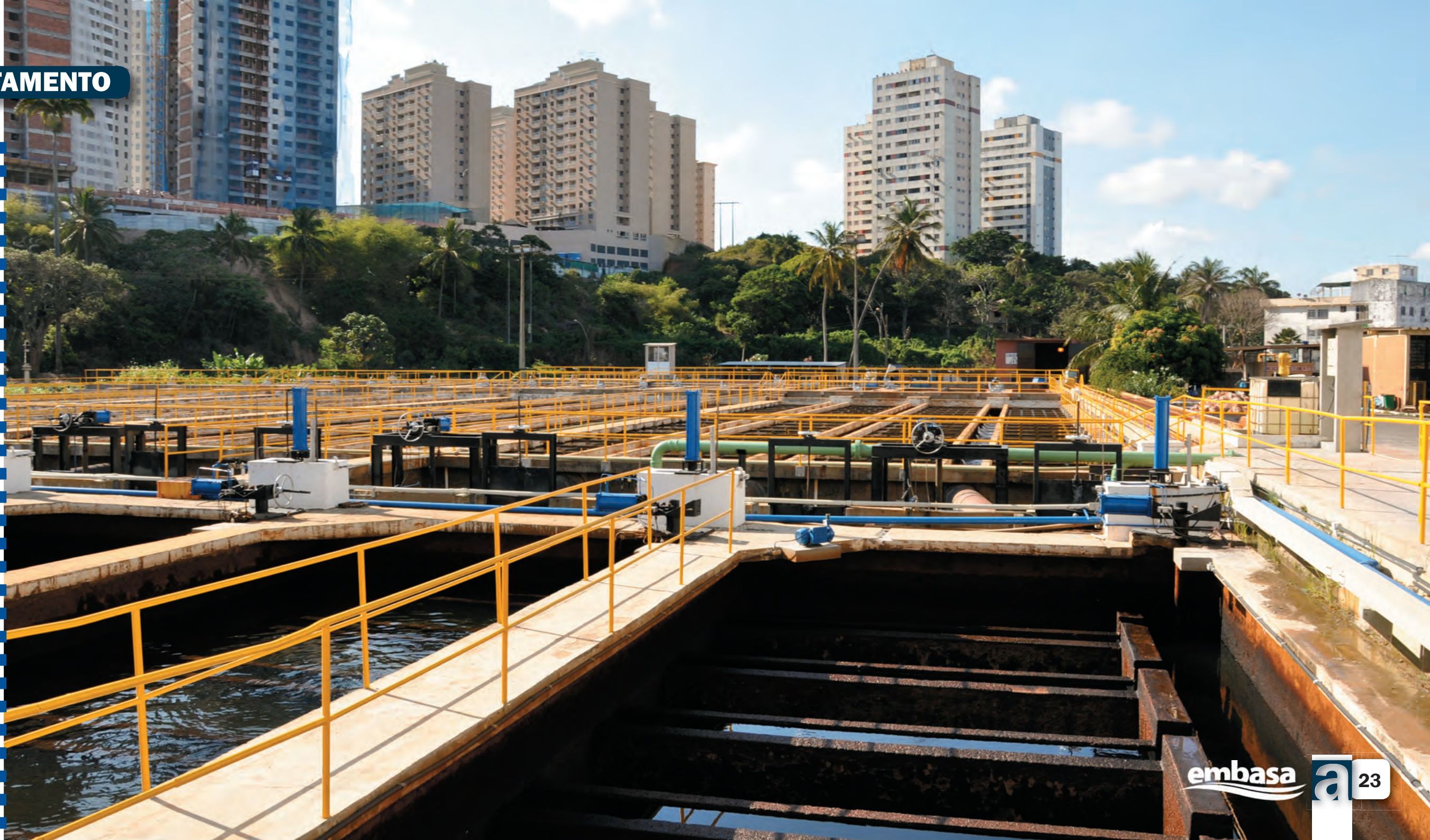
ETA Vieira de Melo no Parque da Bolanadeira
