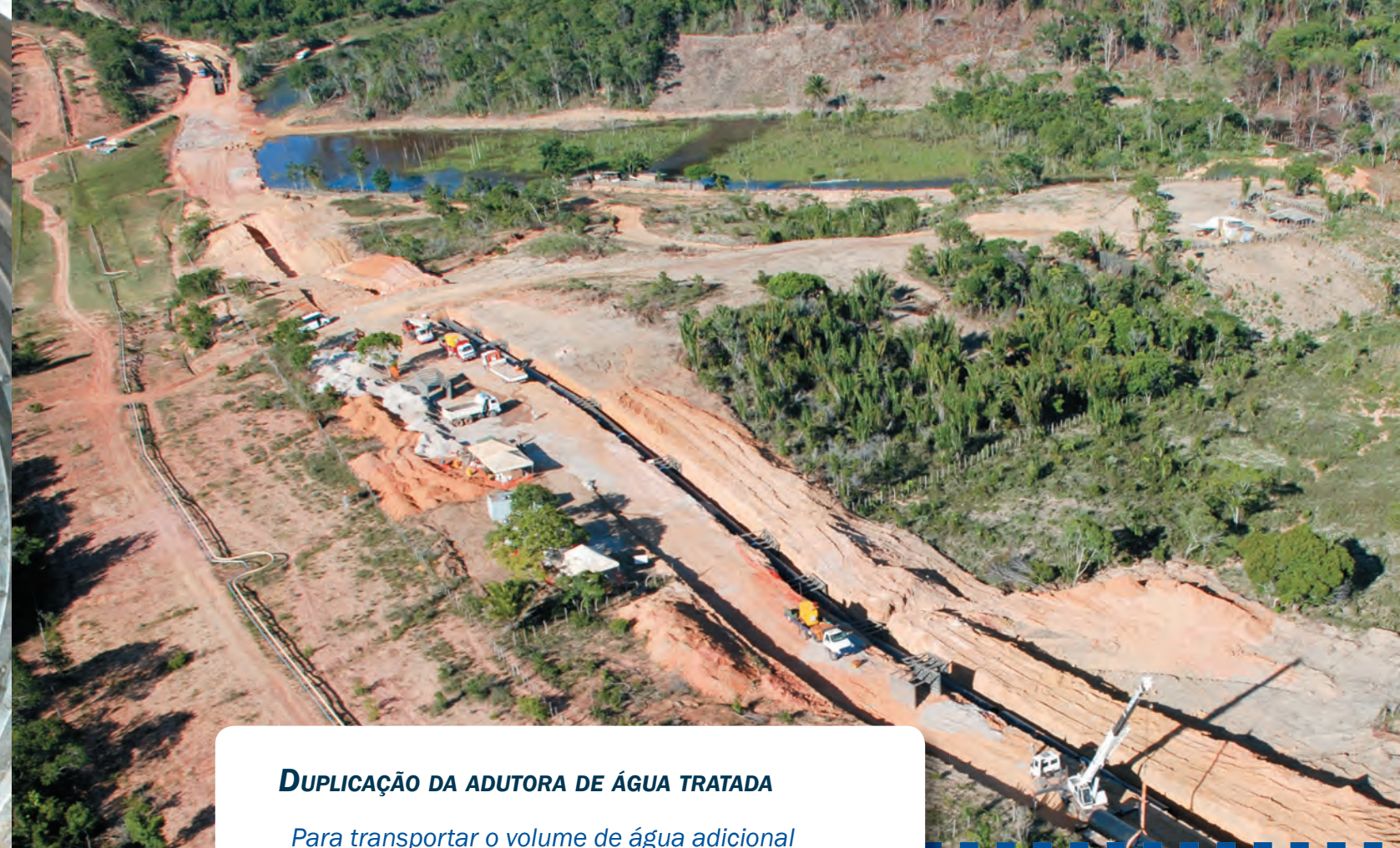
Vista aérea das obras de duplicação da adutora de água
