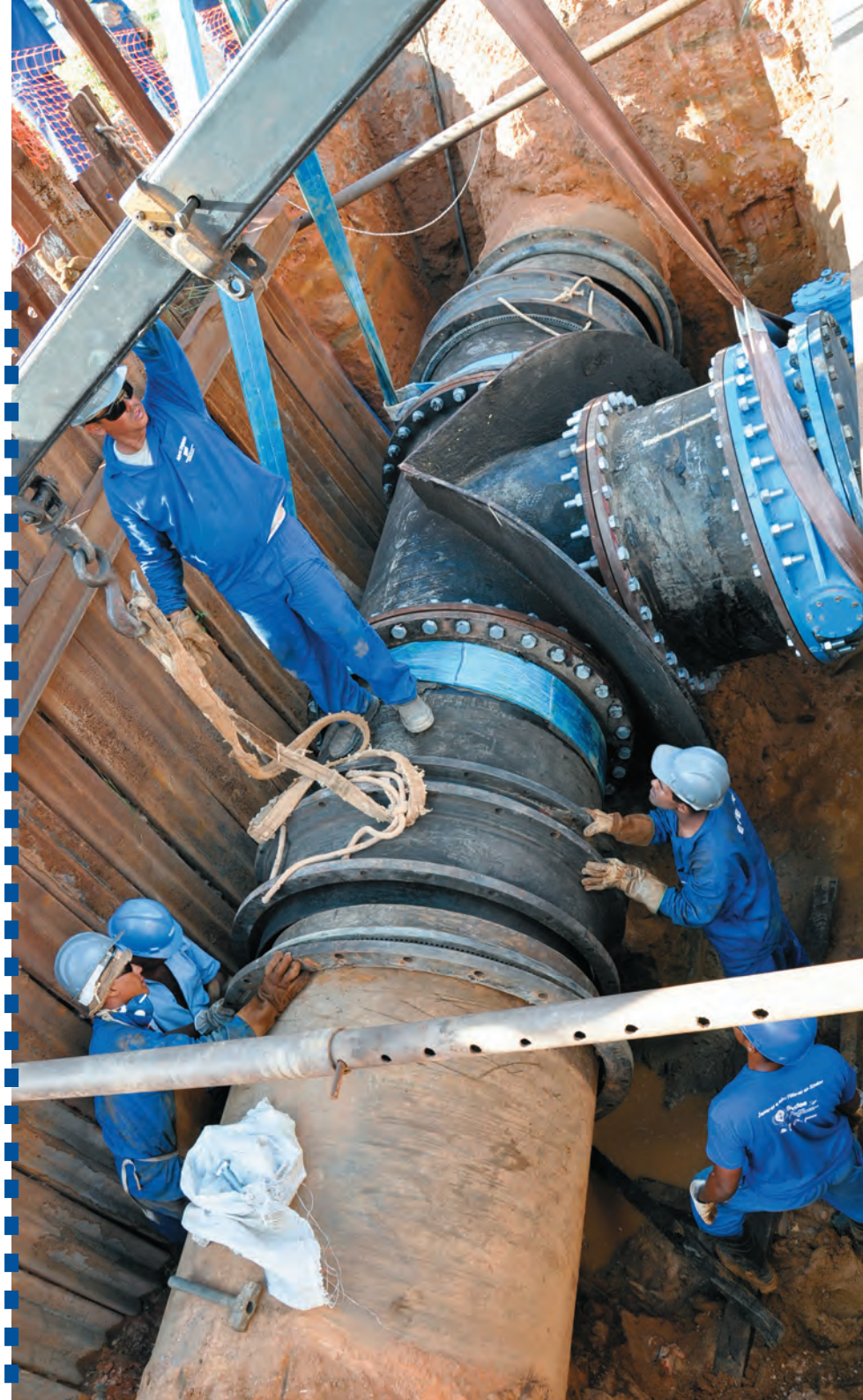
Obra do entroncamento Porto Seco e Valéria
