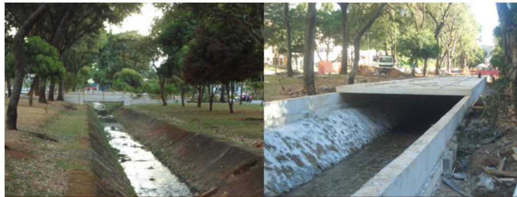
Figura 27 – Rio dos Seixos antes e após as intervenções sob seu leito, 2005 e 2008
