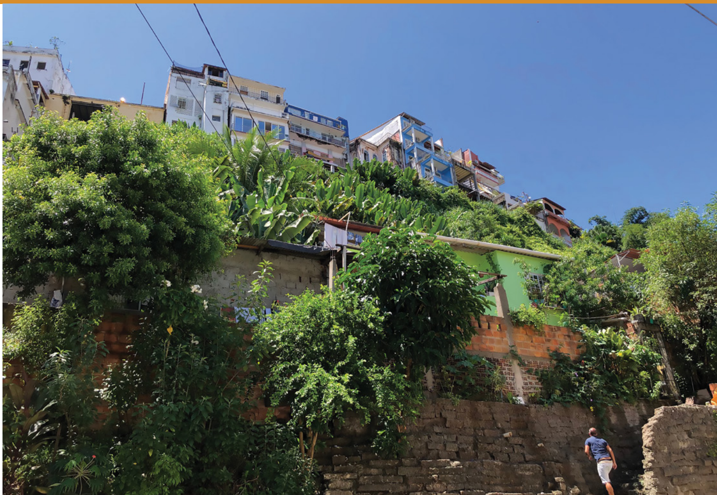
Figura 26. Ocupação irregular na encosta. FMLF, 2021.
