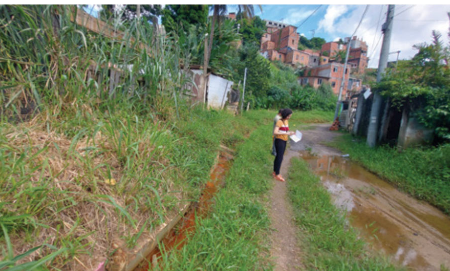
Figura 52 - Microdrenagem precária na comunidade de Três Manguueiras. Fonte: FMLF, 2023.
