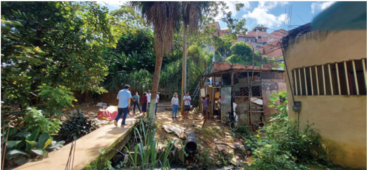
Figura 50 - Lançamento de esgoto in natura em córrego, em Padre Ugo, na ZEIS Canabrava. Fonte: FMLF, 2024.
