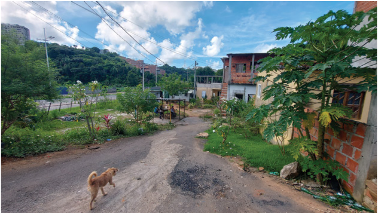
Figura 27 - Área inundável à margem da Avenida Mário Sérgio Pontes de Paiva. Fonte: FMLF, 2023.
