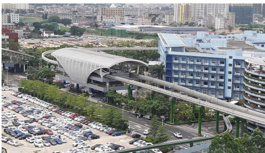
FIGURA 3.3.4.A - ESTAÇÃO DE MONOTRILHO PROTÓTIPO - DA SKYRAIL - EM SHENZHEN 18
