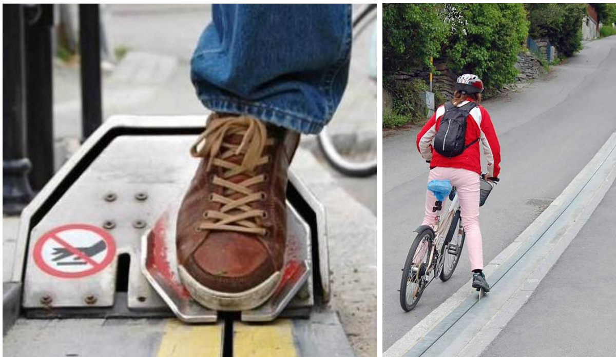
FIGURA 5.3.2.A - DETALHES DO PEDAL/PLATAFORMA E DO USO DO CYCLOCABLE 53
