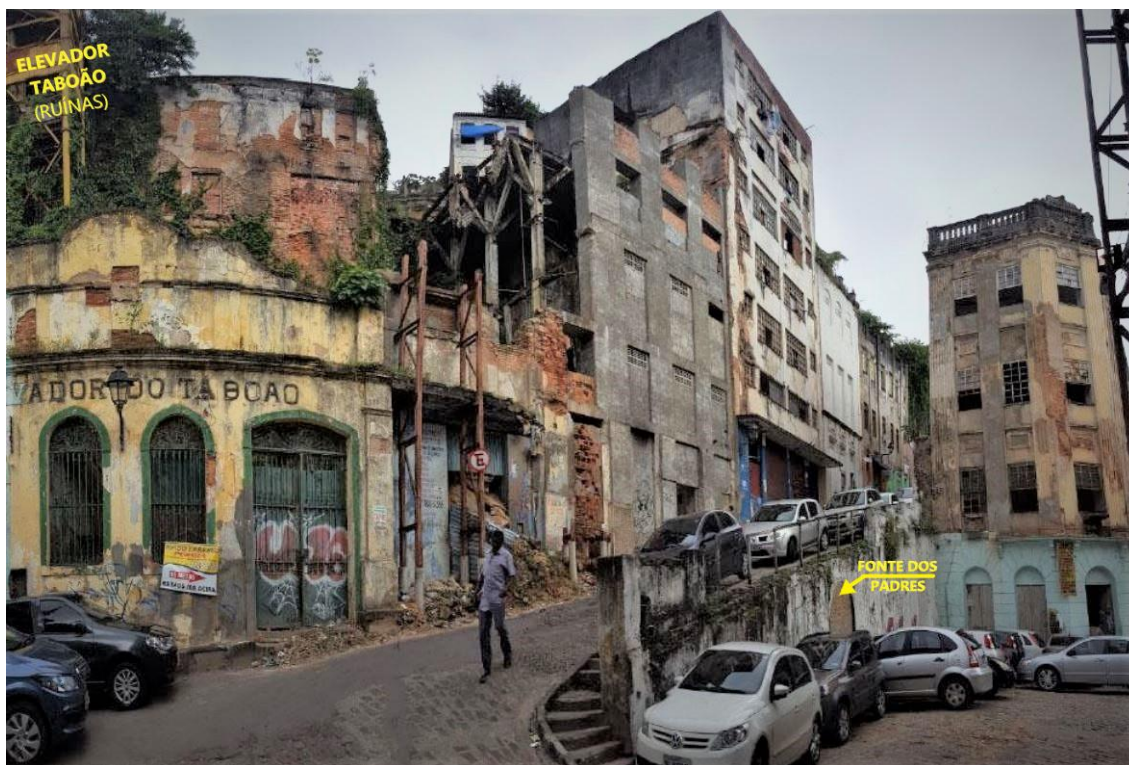
Figura 4.13 - LOCALIZAÇÃO DA FONTE DOS PADRES (SOB A RUA/ LADEIRA DO TABOÃO) 20
