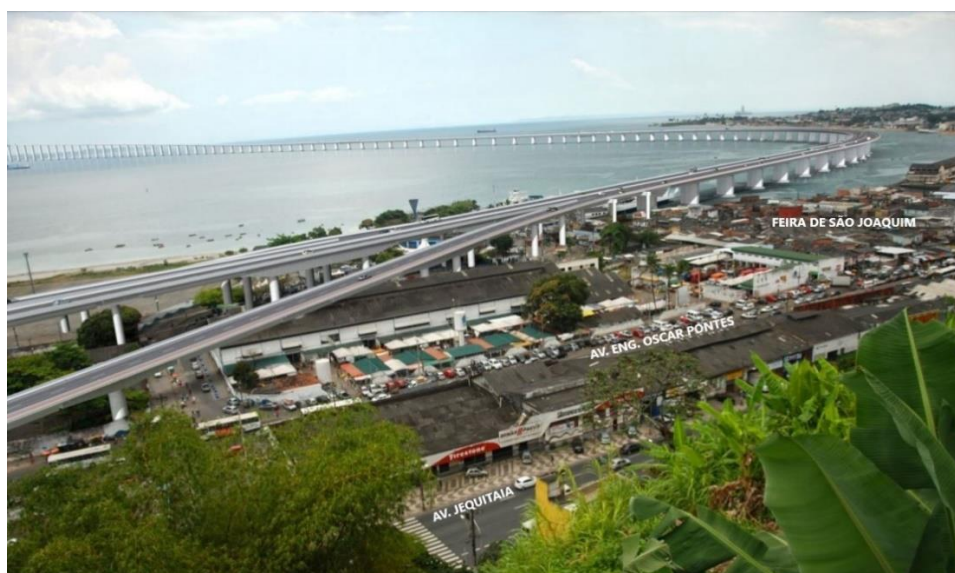
Figura 4.7 MONTAGEM GRÁFICA DA PONTE SALVADOR-ITAPARICA NA REGIÃO CONTINENTAL 8
