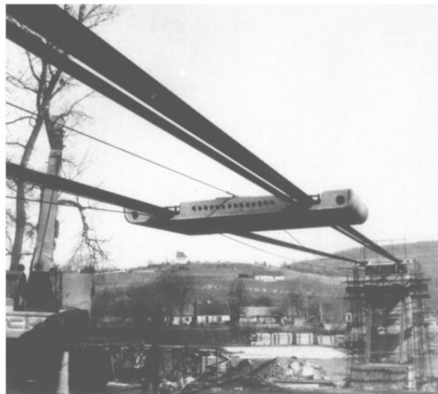
Elemento pré-moldado sobre os cabos de sustentação.
