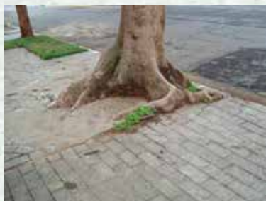
Fig. 20 - Errado: Sufocamento da raiz, impermeabilização e futuros problemas, como quebra de calçada.
