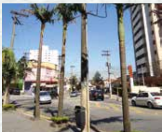
Fig. 26 - Errado: Plantio de palmeira sob fiação elétrica, e poda drástica para evitar o contato com os fios.
