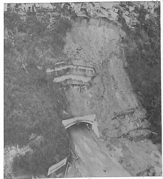
Escorregamento sobre o túnel Américo Simas.
