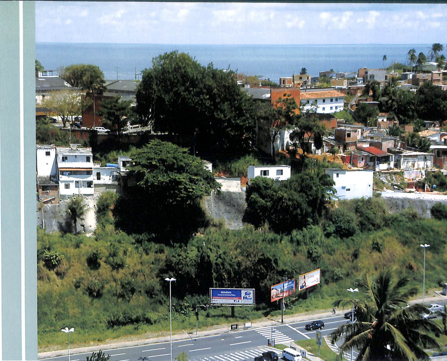
Uma das técnicas de contenção de encostas combina cortina de concreto e revestimento vegetal, como é o caso da Avenida Garibaldi.
