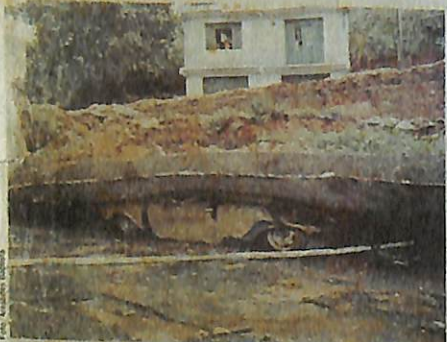
Muro de contenção desabou e esmagou um automóvel em São Marcos
