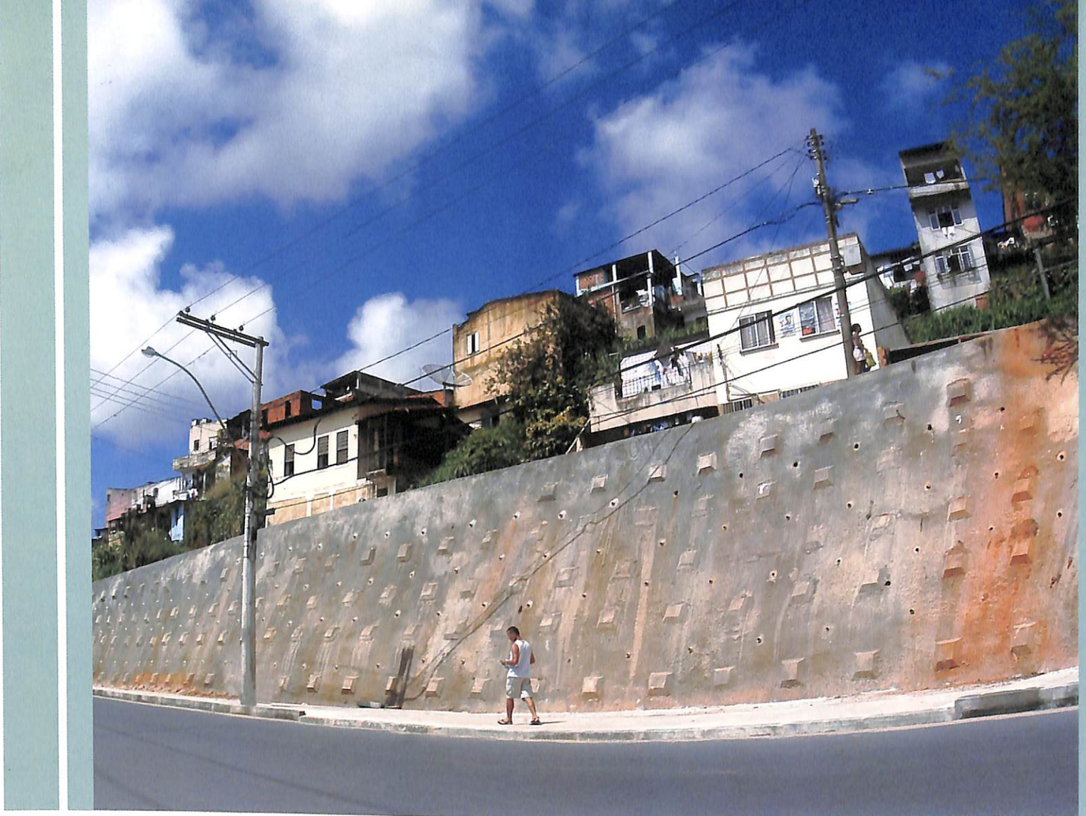
Estrada da Rainha: contenção com cortinas atirantadas de concreto armado.
