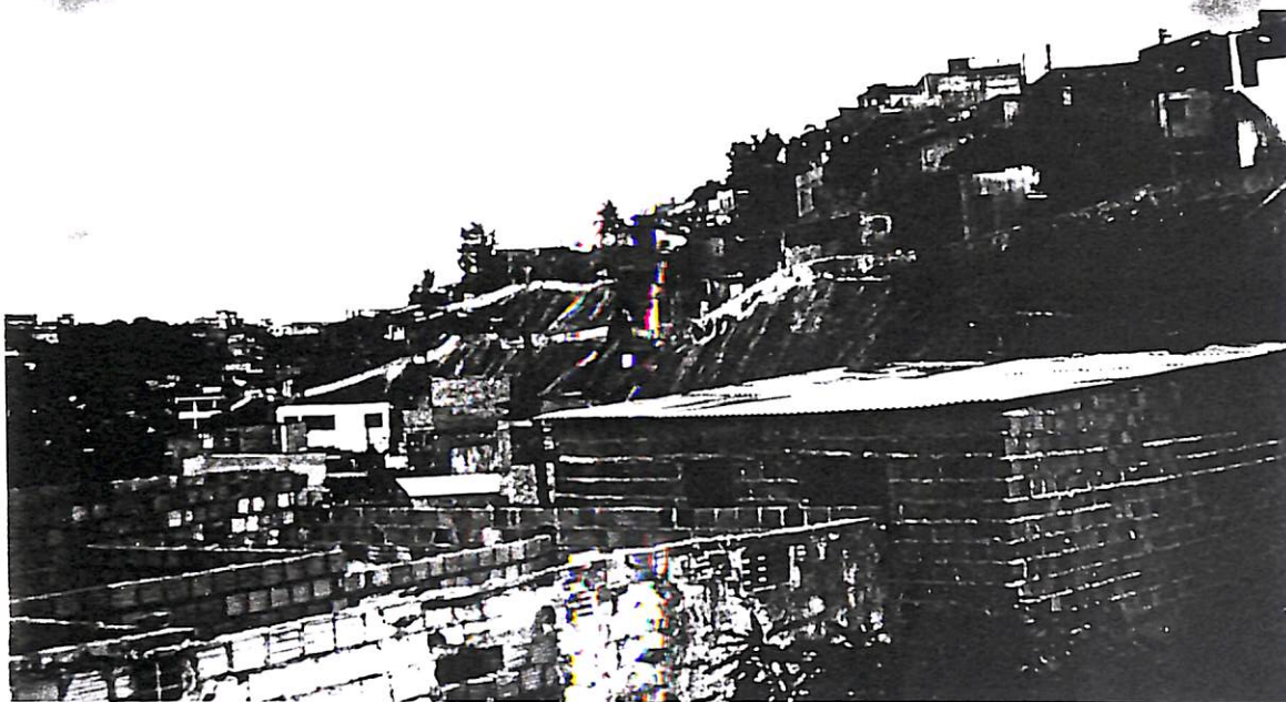
Área degradada com altos investimentos em obras de estabilização de péssimo aspecto visual - Bom Juá
