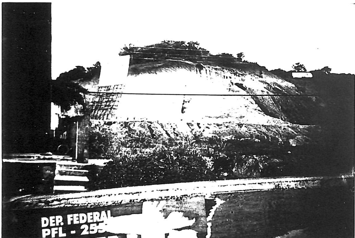
Area degradada por cortes exagerados - Em frente a Rodoviária
