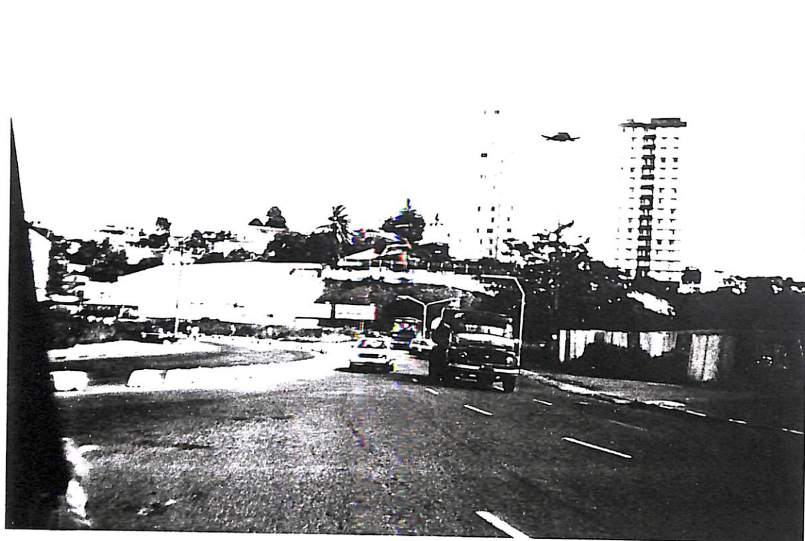
Revestimento de encosta com forte impacto sobre a paisagem natural - Av. Centenário - Rótula dos Barris
