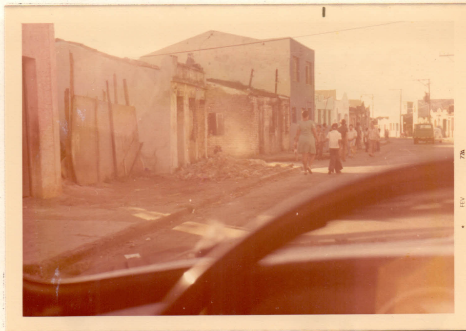
FIG. 4 - Entulho de construção na Rua Cosme de Farias.
