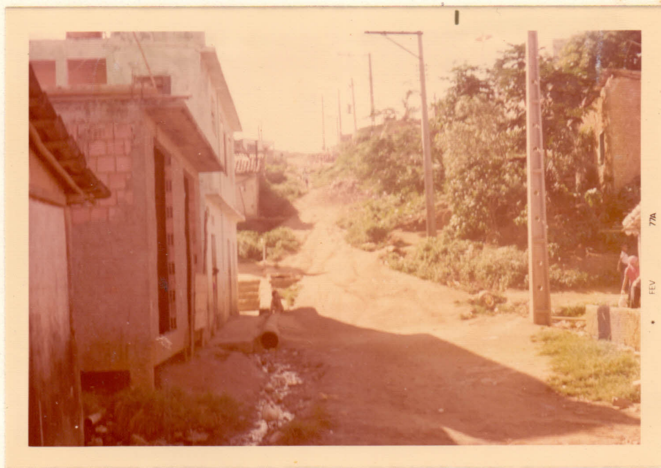
FIG. 5 - Ladeira Padre José, Alto da Santa Cruz, vendo-se as canalizações de águas pluviais que são obstruídas pelo carreamento do lixo depositado no seu leito.
