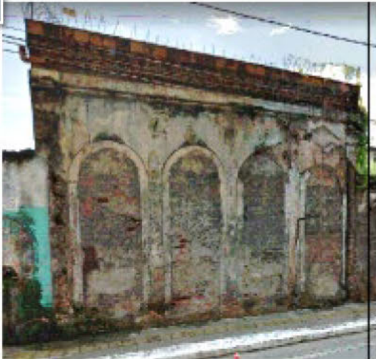
FACHADA Ladeira da Montanha, Lote 30
