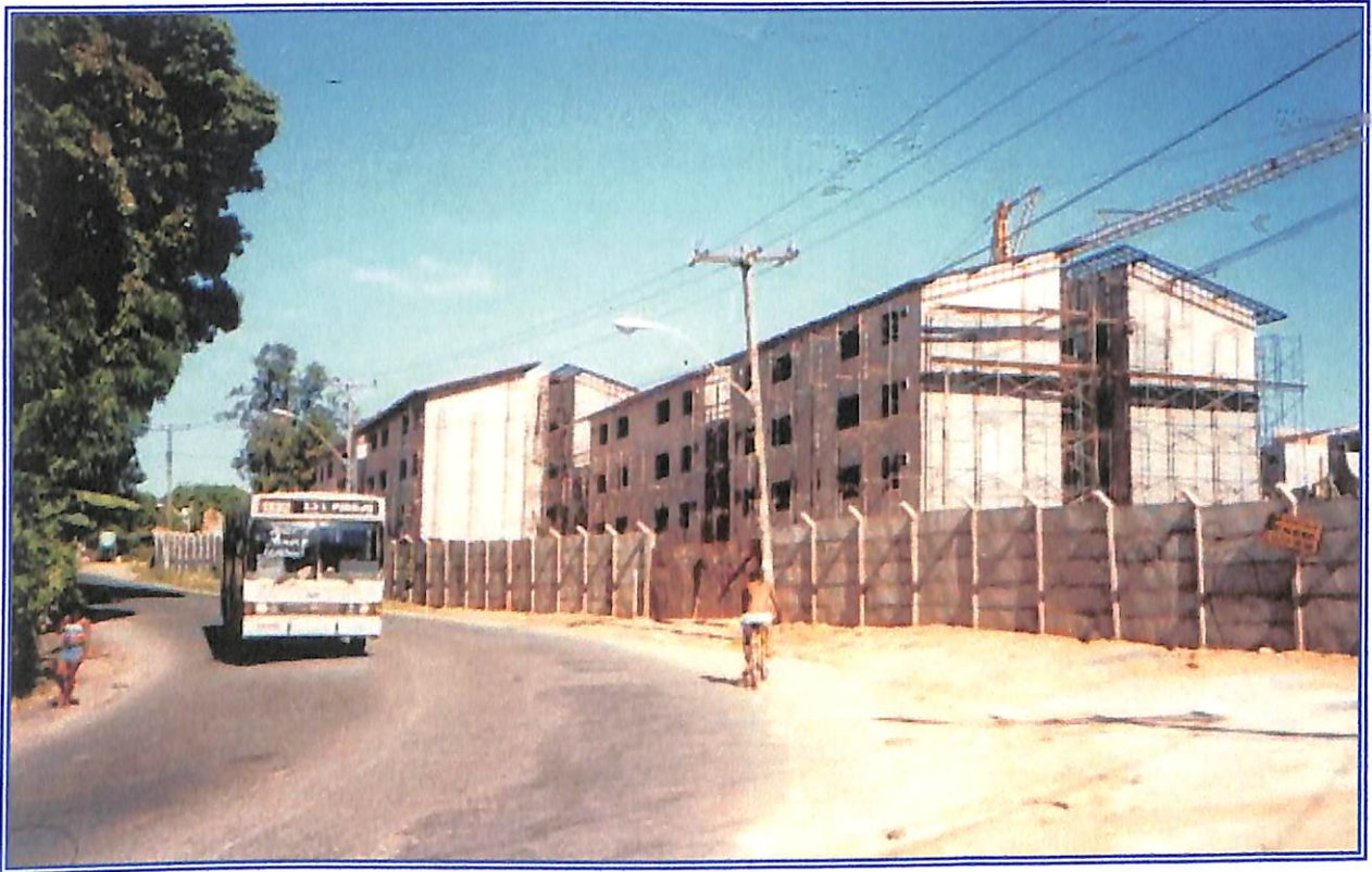
Foto 12. Empreendimento financiado pelo PAR na Estrada Velha do Aeroporto, em construção
