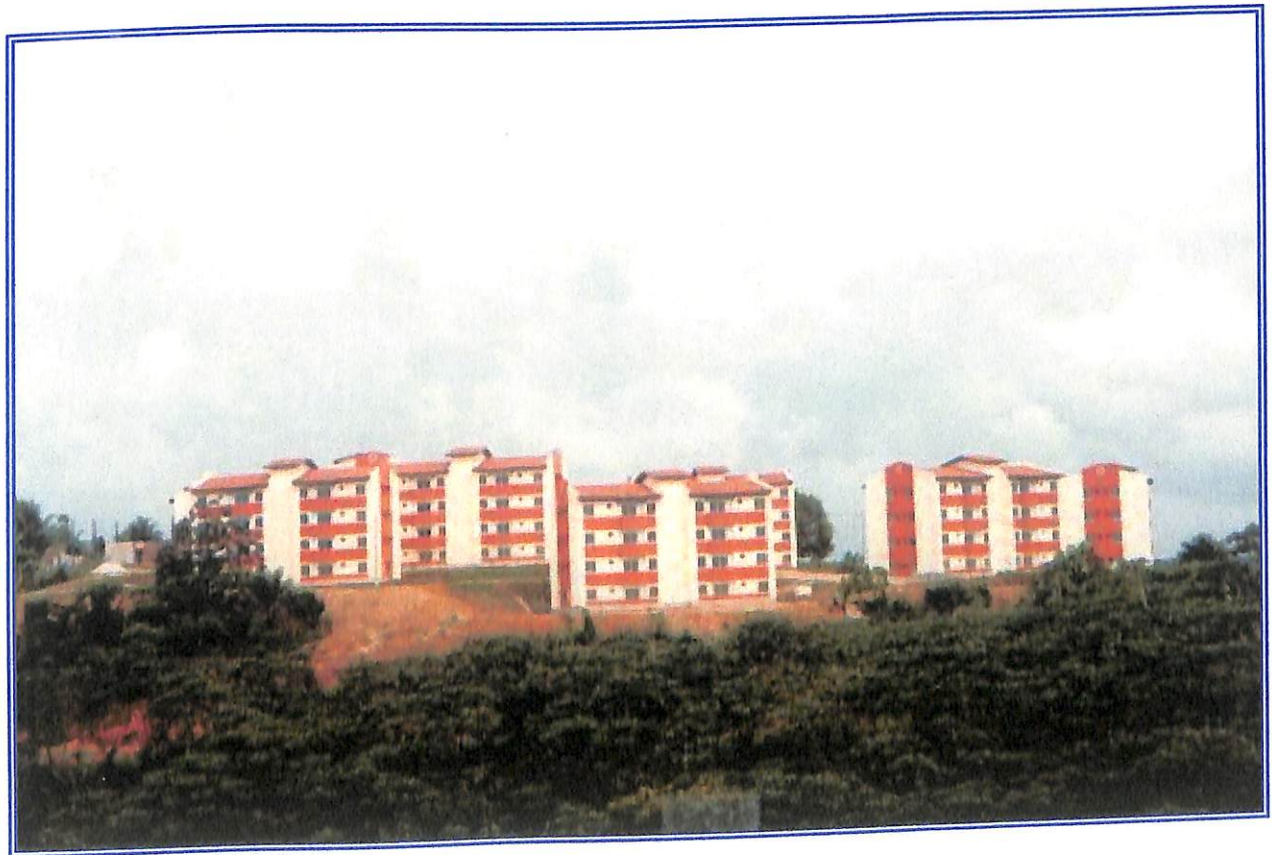
Foto 11. Empreendimento financiado pelo PAR na Estrada Velha do Aeroporto, em construção.
