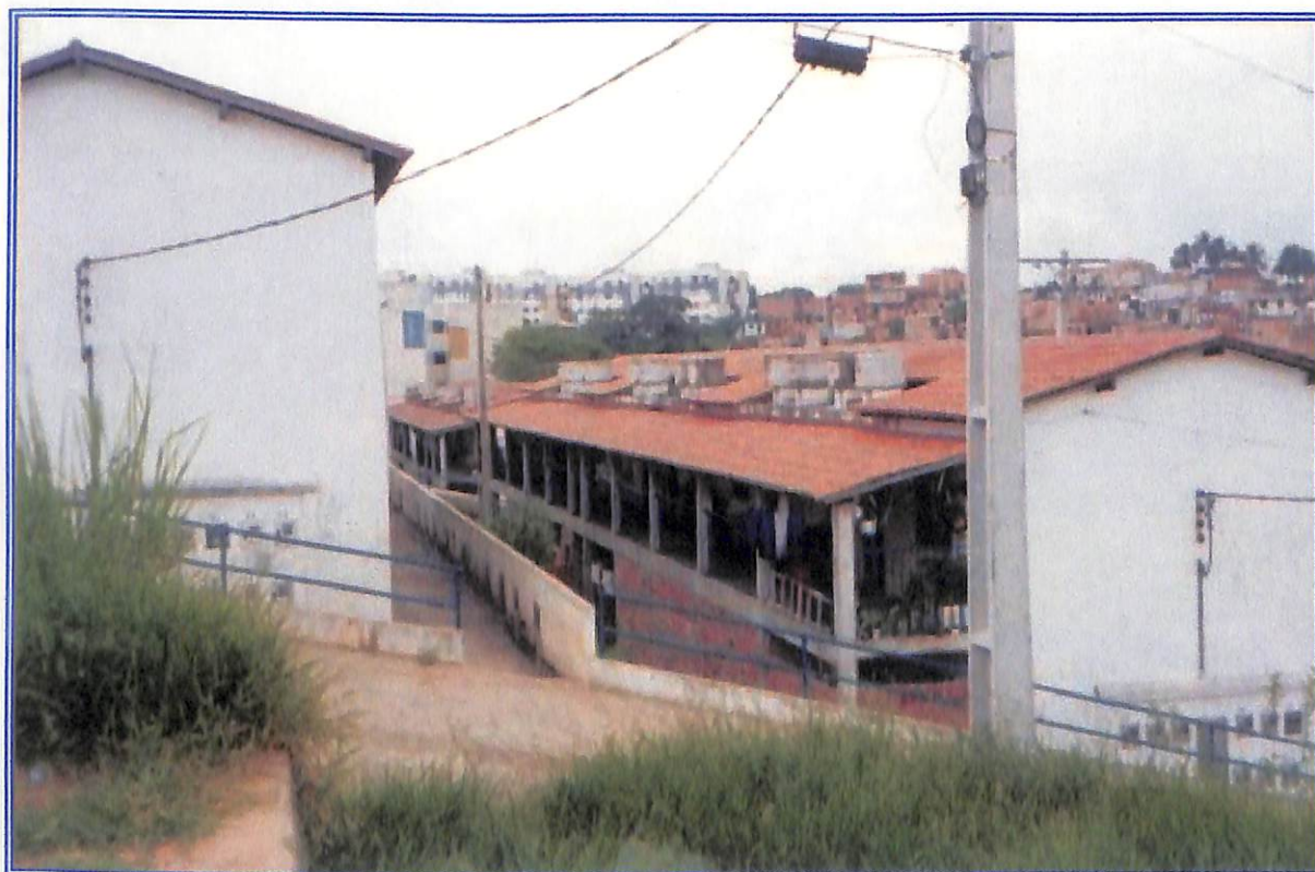
Foto 43. Intervenção da URBIS em área de risco em Santo Inácio.
