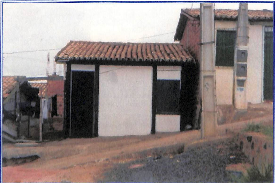
Foto 41. Intervenção da URBIS em área de risco em Santo Inácio.
