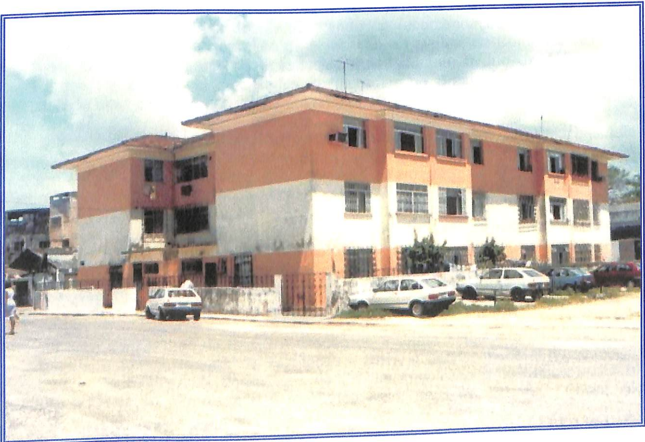
Foto 3. Detalhe de um dos blocos do Núcleo Residencial Castro Alves.
