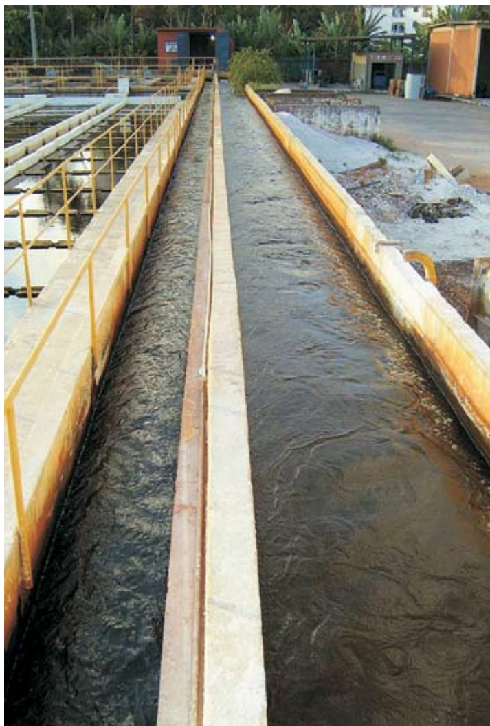
Etapa de filtragem da água
