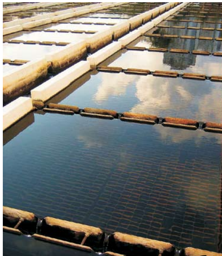
Etapa de decantação da água
