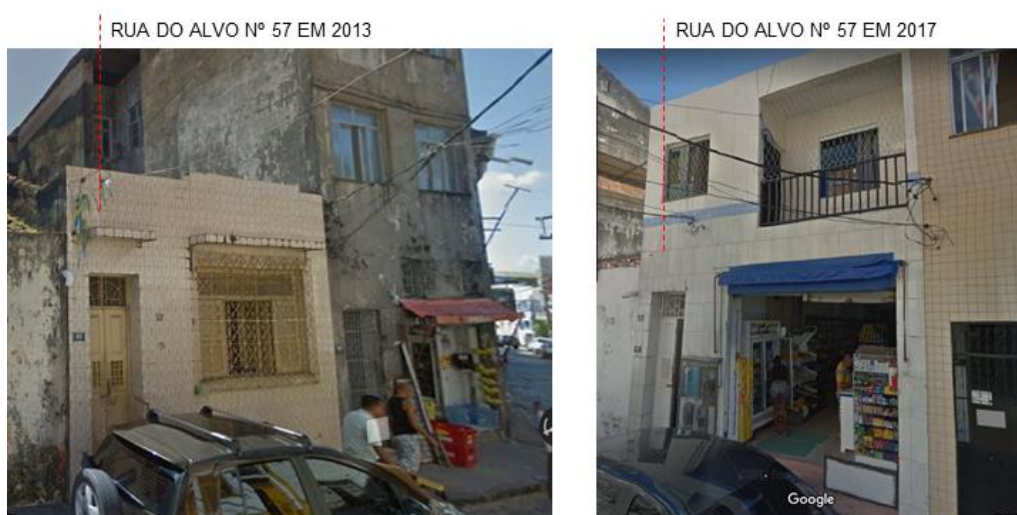
Figura 23 - Imóvel sito a Rua do Alvo nº 57 em 2013 e 2017.
