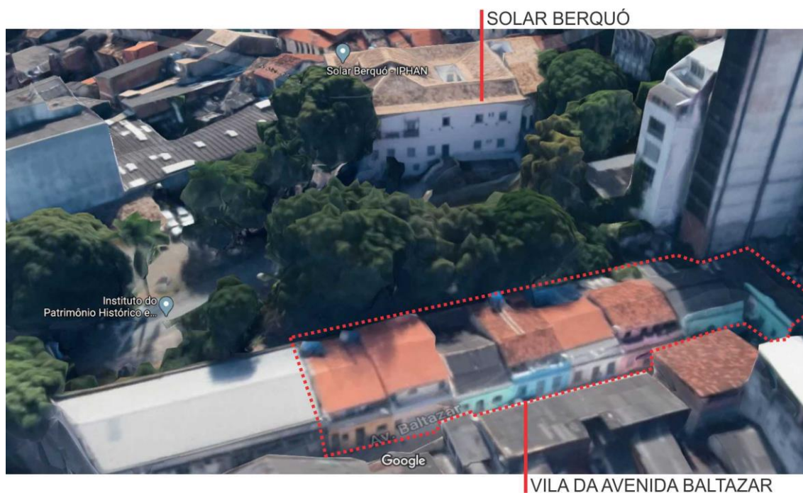
Figura 4 - Avenida Baltazar e Solar Berquó.
