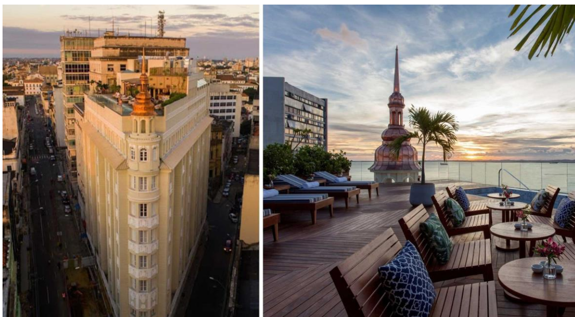
Figura 10 - Intervenção na Cobertura do Hotel Palace
