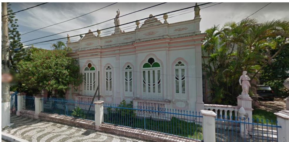
Figura 21 - Edificação à Praça Colombo
