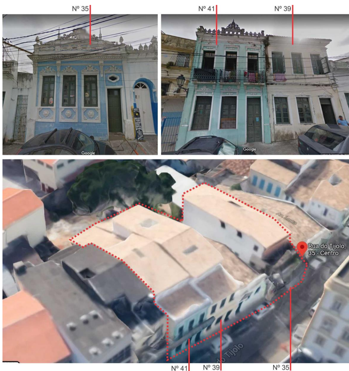
Figura 15 - Imóveis da 7ª Etapa à Rua do Tijolo
