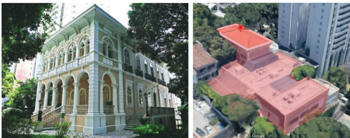
Figura 18 – Solar Cunha Guedes – Avenida Sete de Setembro, 2445.
