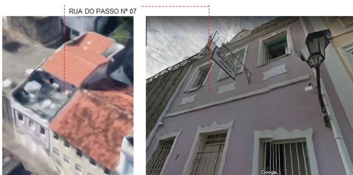
Figura 12 - Imóvel sito à Rua do Passo Nº 07, com perspectiva mostrando o terraço frontal e fotografia da fachada do imóvel.
