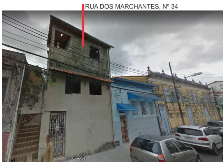
Figura 33 - Imóvel à Rua dos Marchantes, nº 34
