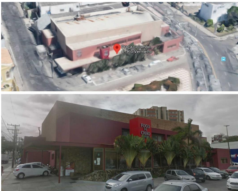
Figura 27 - Imóvel à Praça Colombo, nº 04.
