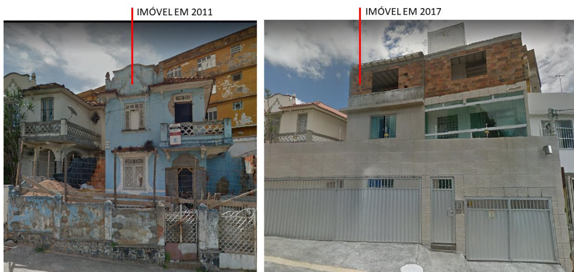
Figura 6 - Imóvel sito à Rua Engenheiro João Pimenta Bastos nº 04, em 2011 e 2017.
