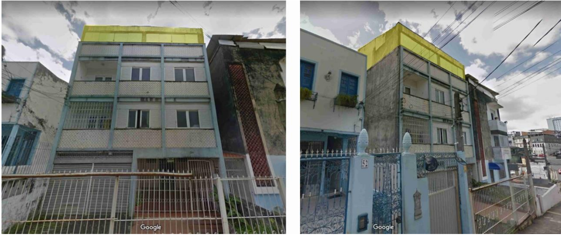
Figura 30 - Imóvel à Rua dos Perdões, nº54.
