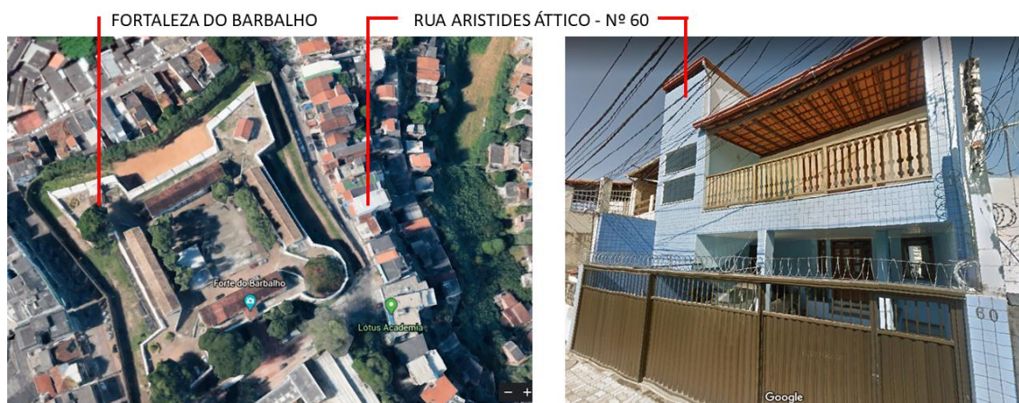
Figura 5 - Localização e fachada do imóvel sito à Rua Aristides Ático nº 60
