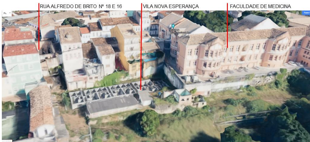
Figura 13 – Vista das obras da Vila Nova Esperança em 2020
