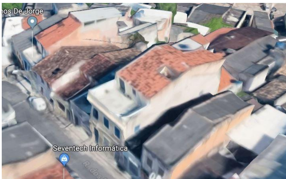
Figura 11 - Rua dos Marchantes - nº 45 | Fonte: Google Street View
