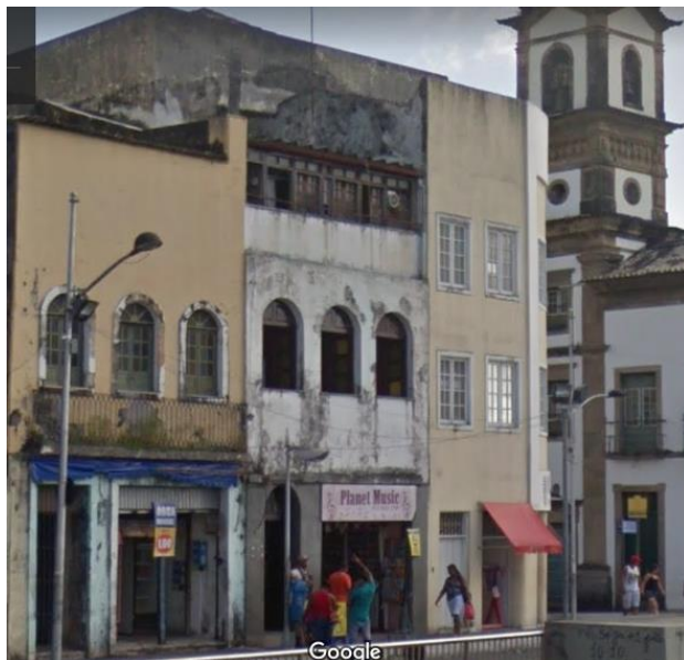
Figura 3 - Imóveis sito na Praça da Sé nº 01, 03, 05 | FONTE: Google Street View
