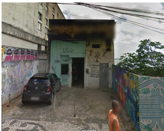
Figura 1 - Imóvel sito à Rua Carlos Gomes, 15
