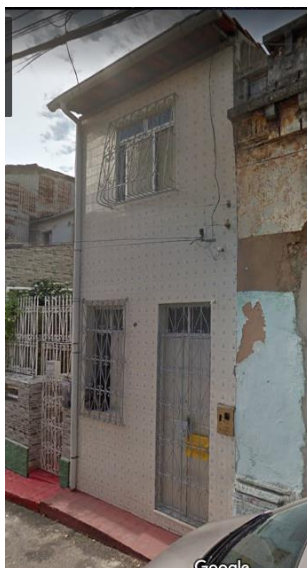
Figura 18 - Imóvel sito à Rua do Genipapeiro nº 54
