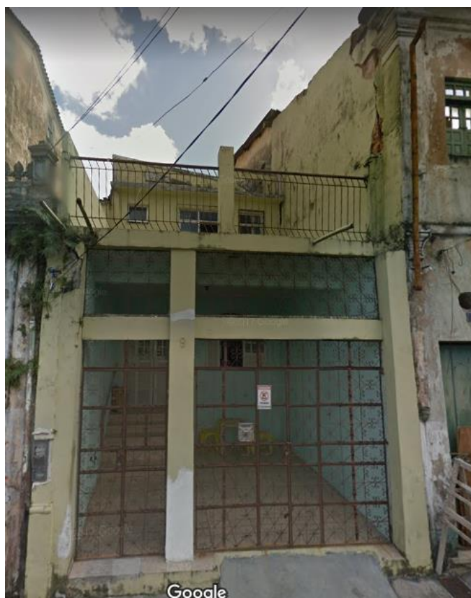
Figura 15 - Rua dos Perdões nº9
