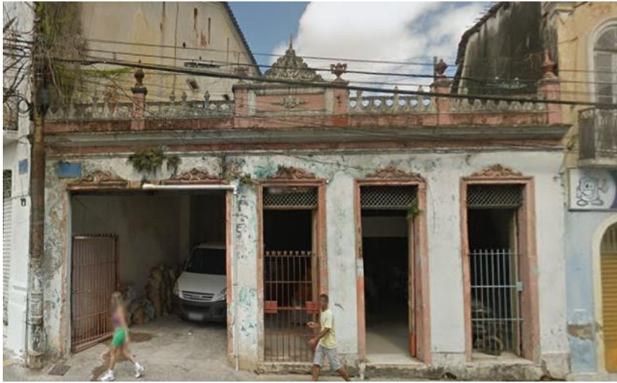
Figura 8- Rua dos Perdões, nº49.
