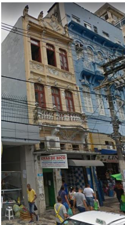
Figura 9 - Imóvel sito a Avenida Sete de Setembro nº 737 e 751
