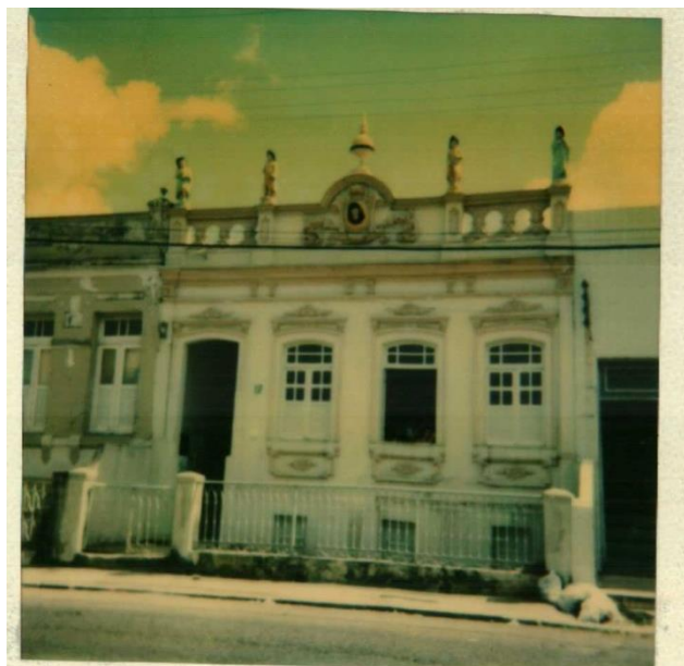
Figura 41 - Rua Teodósio Rodrigues de Farias, 12
