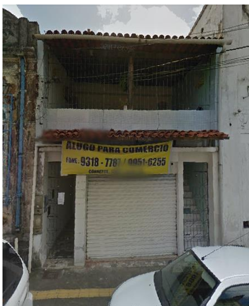
Figura 33 - Rua dos Perdões nº 40
