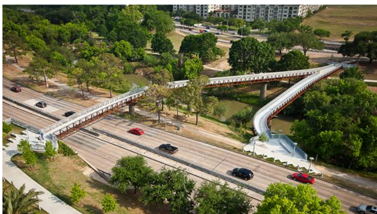
Figura 13 - Exemplo: Ponte de Pedestres Rosemont, Texas, EUA
