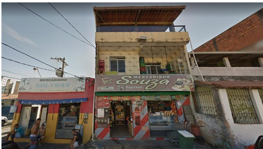
Figura 50 - Edificações de uso misto, Rua Bem-Te-Vi Fonte: Google Street View (2022)
