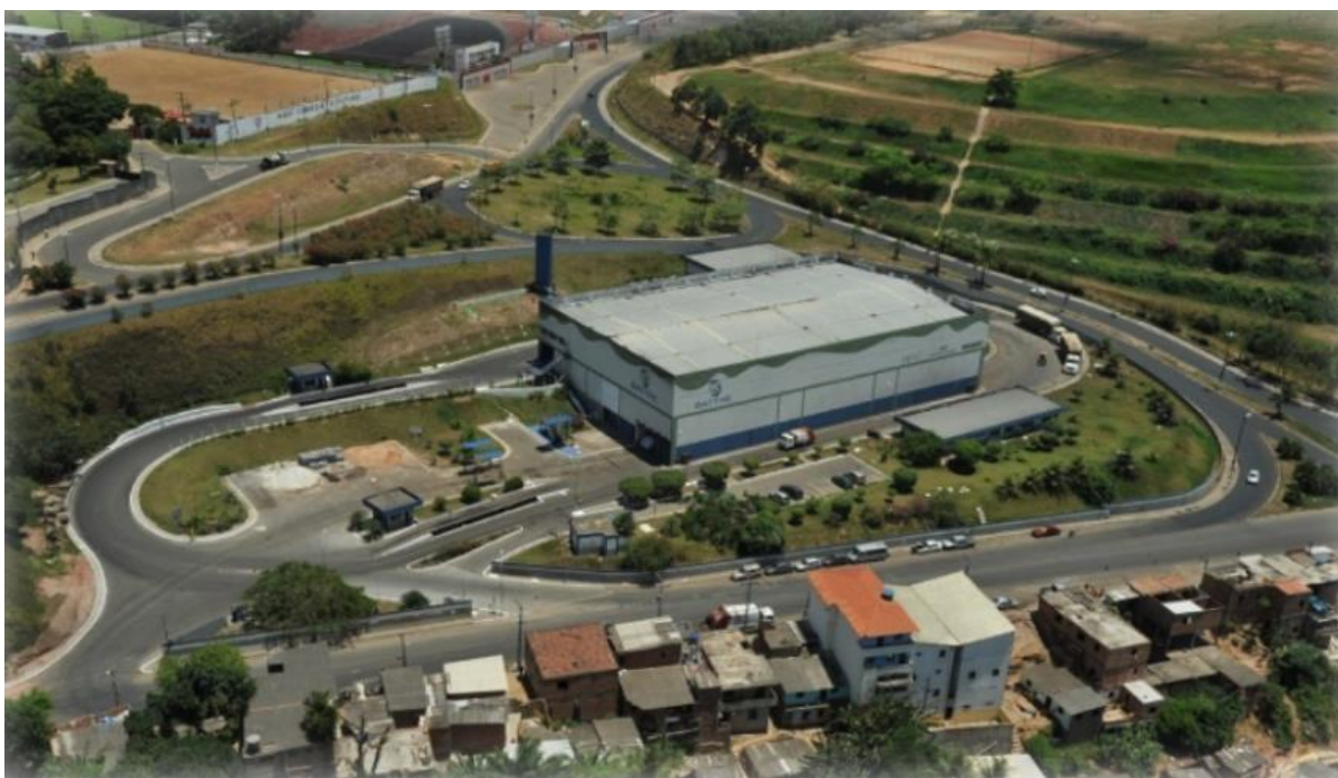
Figura 161 - Vista geral da Estação de Transbordo
