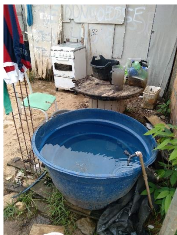
Figura 146 - Exemplo de ligações irregulares Fonte: Autoria da equipe de campo, 12/2022
