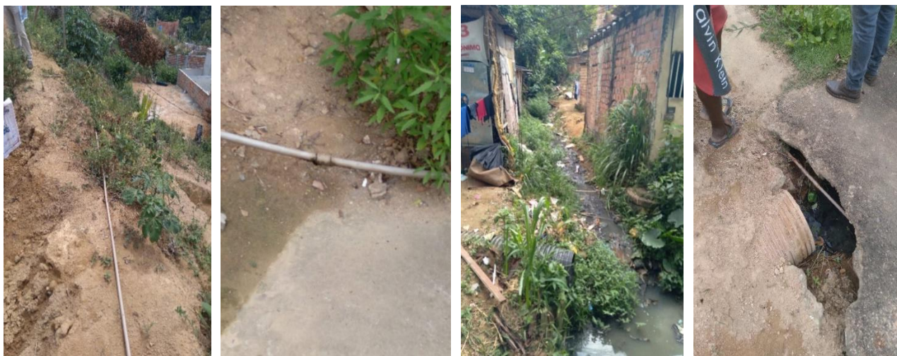
Figura 146 - Exemplo de ligações irregulares Fonte: Autoria da equipe de campo, 12/2022
