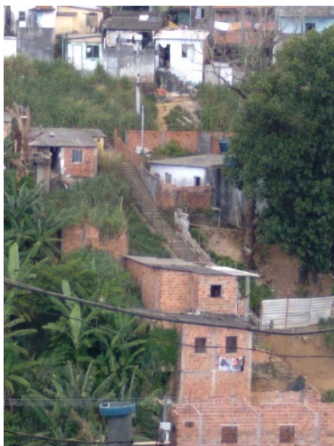
Figura 168 - Algumas localidades sujeitas a desastres: ocupações consolidadas em encostas íngremes Fonte: Autoria da equipe de campo, 12/2022
