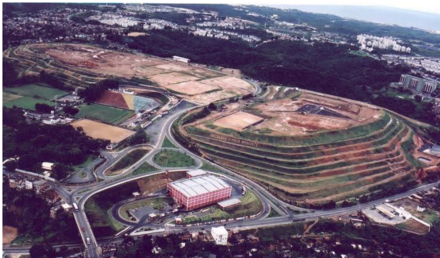
Figura 32 - Os dois “morros” de lixão cobertos de argila, com a BATTRE em primeiro plano Fonte: Oliveira (2017)
