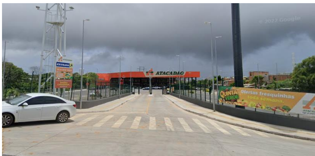
Figura 51 - Atacadão Trobogy Canabrava Fonte: Google Street View (2022)
