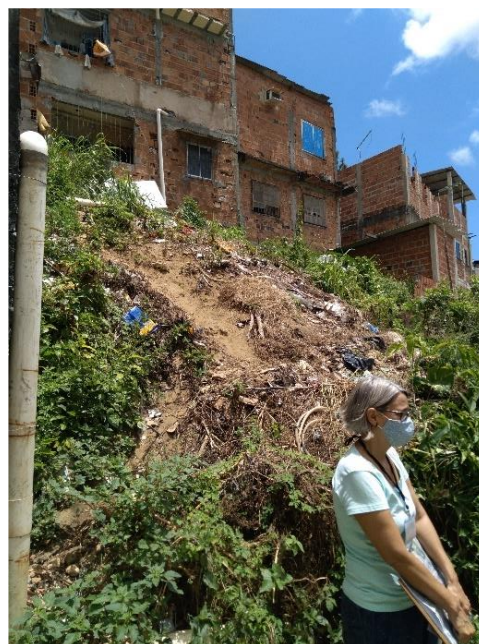
Figura 169 - Algumas localidades sujeitas a desastres: acúmulo de resíduos sólidos na encosta Fonte: Autoria da equipe de campo, 12/2022
