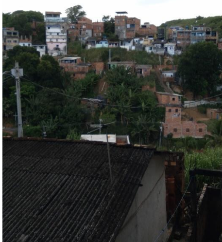
Figura 172 - Algumas localidades sujeitas a desastres: ocupações consolidadas em encostas íngremes
