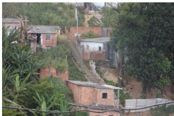
Figura 111 - Escadarias na ZEIS Canabrava Fonte: Autoria da equipe de campo, 12/2022
