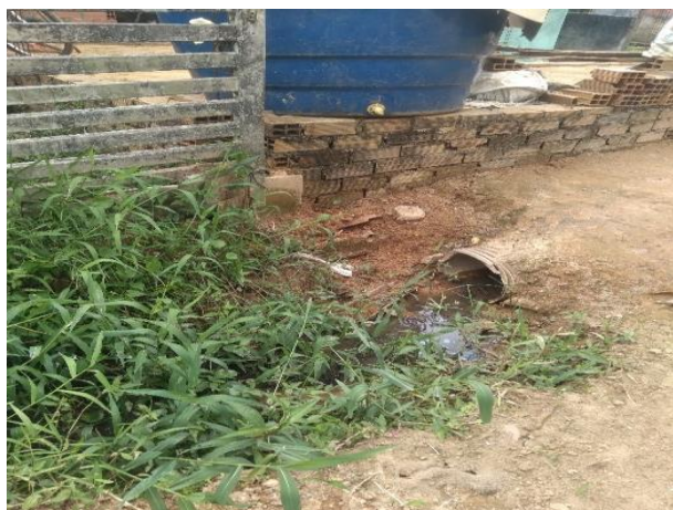
Figura 178 - Condições favoráveis a proliferação de vetores: esgoto a céu aberto próximo a recipiente utilizado para reservação de água
