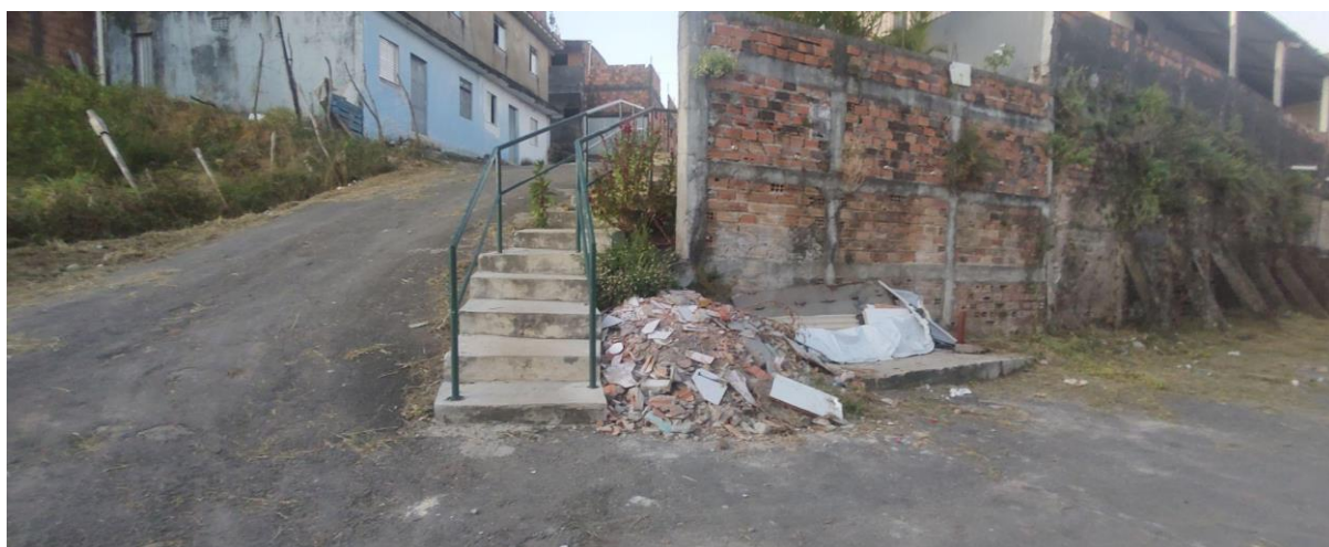
Figura 157 - Descarte irregular de resíduos da construção civil na Rua São Roque
