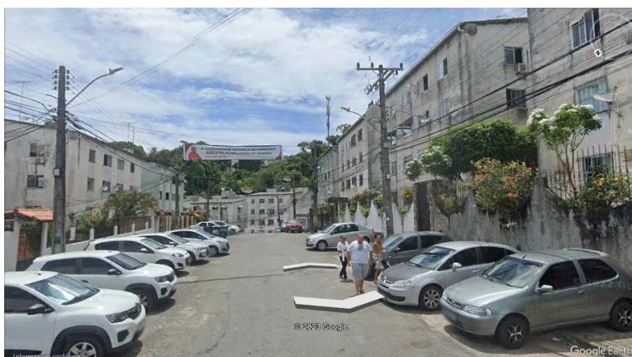
Figura 29 - Vista de um dos eixos do Condomínio Paralela Park Fonte: Google Earth (2021)
