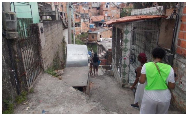
Figura 110 - Escadarias na ZEIS Canabrava Fonte: Autoria da equipe de campo, 12/2022
