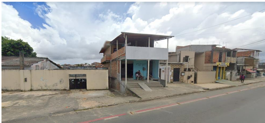
Figura 42 - Ocupação predominantemente horizontal III na Rua Artêmio de Castro Valente Fonte: Google Street View (2022)
