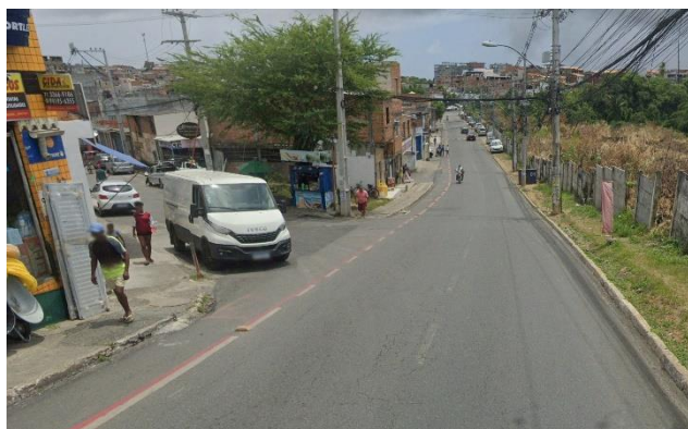
Figura 122 - Interseção viária sem sinalização adequada Fonte: Google Street View (2022)
