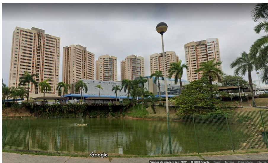
Figura 27 - RVAD na proximidade da Avenida Paralela Fonte: Google Earth (2021)
