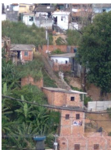
Figura 145 - Exemplo de ocupação não consolidada: Padre Ugo
