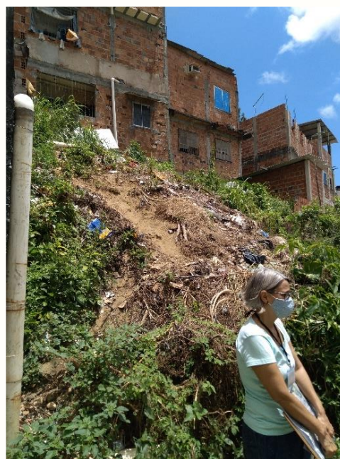
Figura 119 - Algumas localidades sujeitas a desastres: acúmulo de resíduos sólidos na encosta
