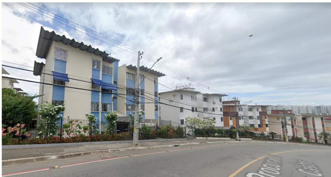
Figura 26 - Conjunto habitacional vertical I na Rua Procurador Nelson Castro
