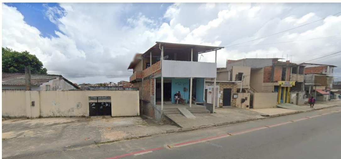
Figura 24 - Ocupação predominantemente horizontal III na rua Artêmio Castro Valente
