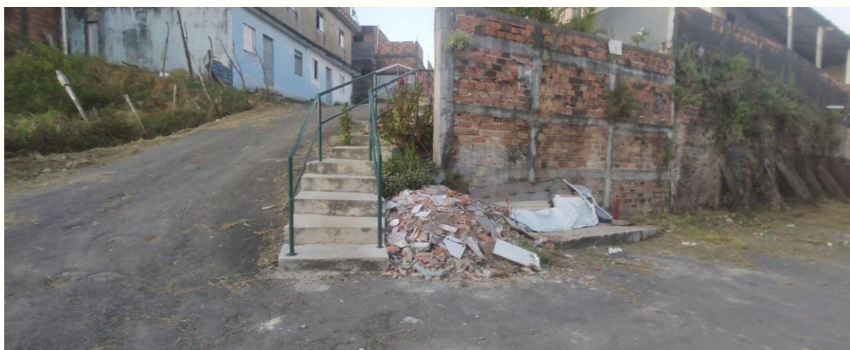
Figura 107 - Descarte irregular de resíduos de construção civil na rua São Roque
