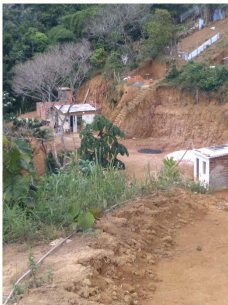
Figura 120 - Algumas localidades sujeitas a desastres: ocupação recente em encostas, Terra Prometida
