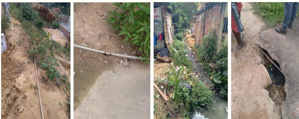
Figura 96 - Exemplo de ligações irregulares Fonte: Autoria da equipe de campo
