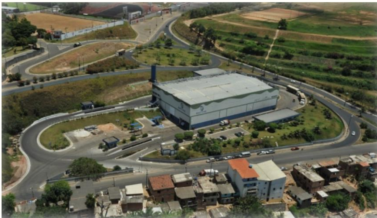
Figura 111 - Vista geral da Estação de Transbordo
