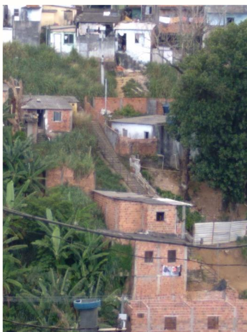
Figura 118 - Algumas localidades sujeitas a desastres: ocupações consolidadas em encostas íngremes
