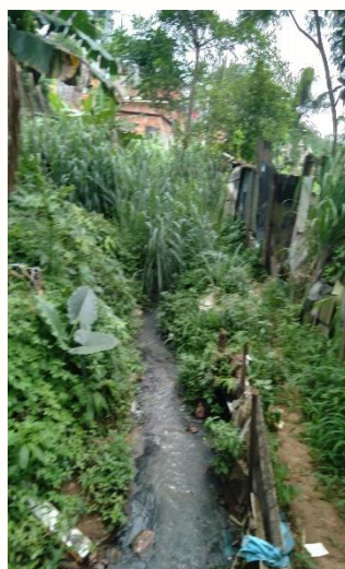
Figura 101 - Exemplo das condições do esgotamento sanitário: escoamento de esgoto a céu aberto
