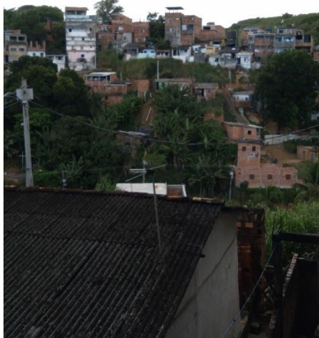
Figura 122 - Algumas localidades sujeitas a desastres: ocupações consolidadas em encostas íngremes
