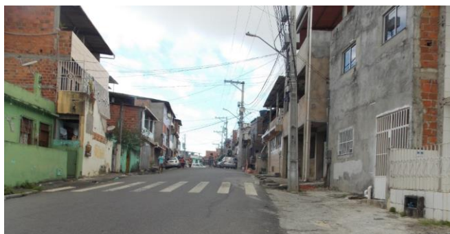
Figura 9 - Calçada precária na Rua Bem-Te-Vi Fonte: Autoria da equipe de campo, 12/2022
