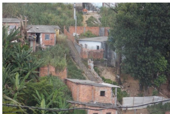
Figura 8 - Escadaria na ZEIS Canabrava II Fonte: Autoria da equipe de campo, 12/2022
