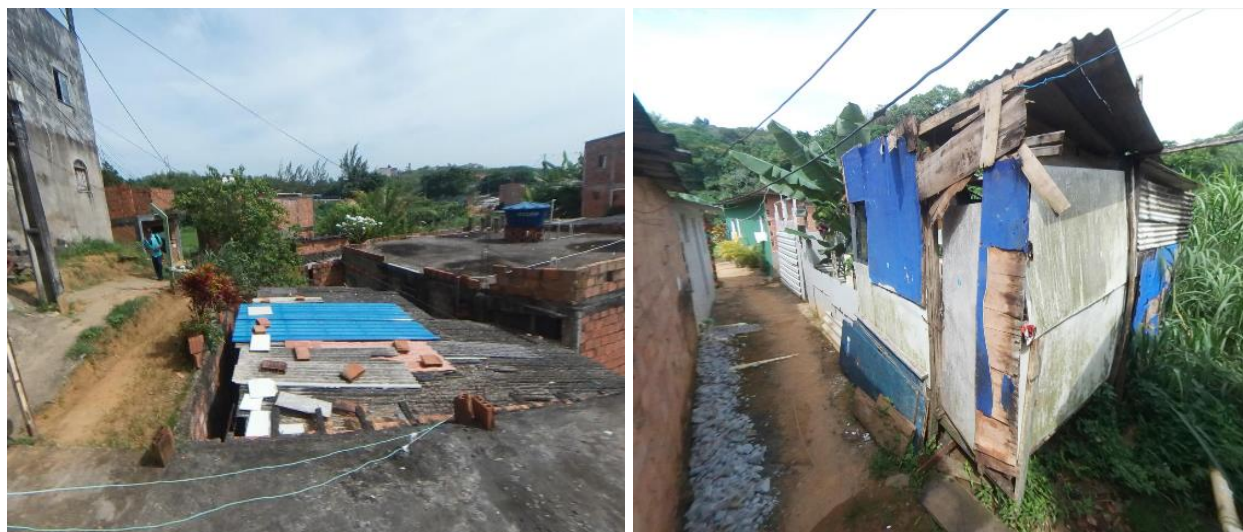
Figura 15 - Edificações precárias em Vila Santinha Fonte: Autoria da equipe de campo, 12/2022
