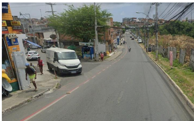
Figura 12 - Interseção viária sem sinalização adequada Fonte: Google Street View (2022)
