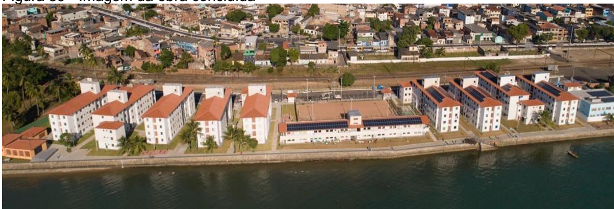
Figura 39 - Imagem da obra concluída
