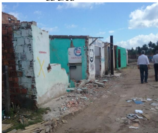
Figura 37 - Foto da obra após desocupação da área
