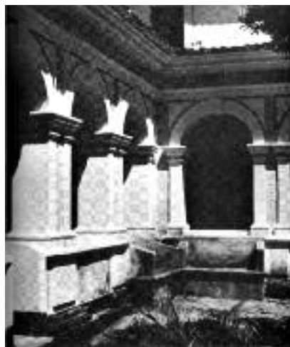
Claustro do convento antes da reforma, em 1956. Cloister of the convent before the reform, in 1956.
