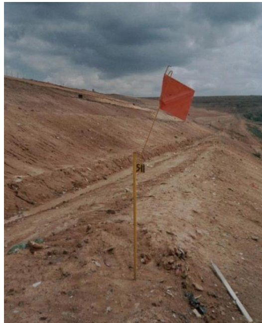
Foto 9.1 – Medidor de recalque superficial instalado e identificado..
