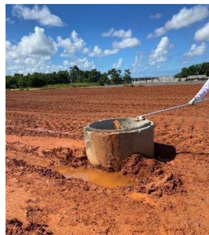
Foto 3.6: Terminal de dreno PVC teste de de queima no DG 8 – , campanha 03/05/2
