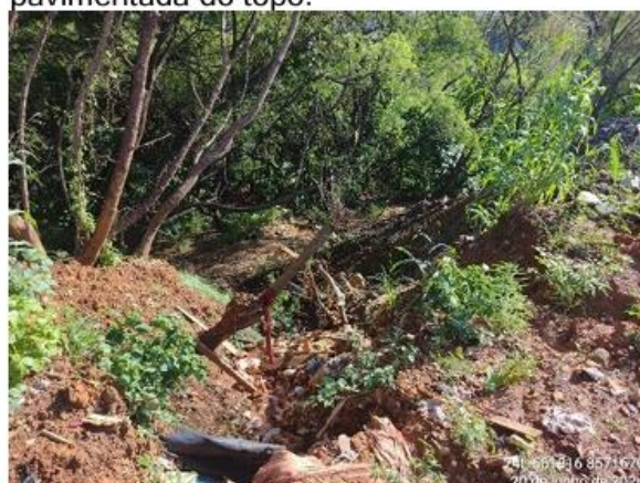
Foto 8.12 - Voçoroca provocada pela drenagem pluvial.
