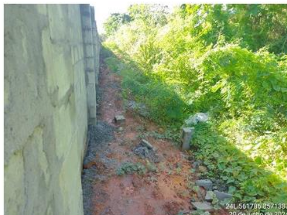
Foto 8.10 – Muro lateral terreno a área não pavimentada do topo.
