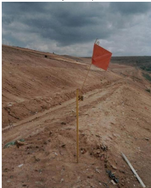
Foto 9.1 – Medidor de recalque superficial instalado e identificado..
