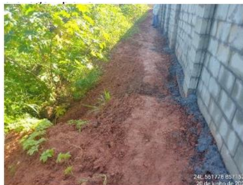
Foto 8.6 - Distância muro a topo de talude.
