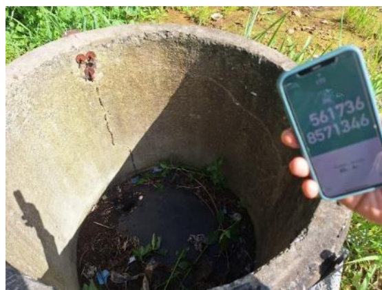
Foto 3.8: Terminal de dreno PVC teste de queima no DG 11– campanha 03/05/24
