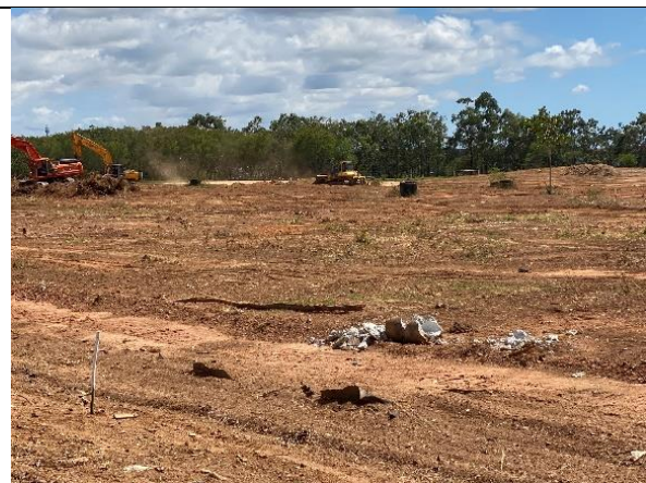
Foto 1: Vista da área, topo do aterro.
