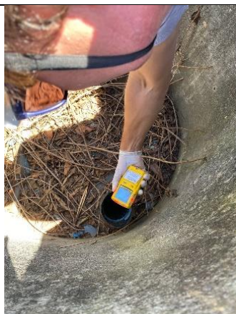
Foto 5: Verificação das concentrações de gases ( H_2S , CO, O_2 , LEL).
