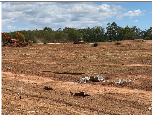
Foto 1: Vista da área, topo do aterro.
