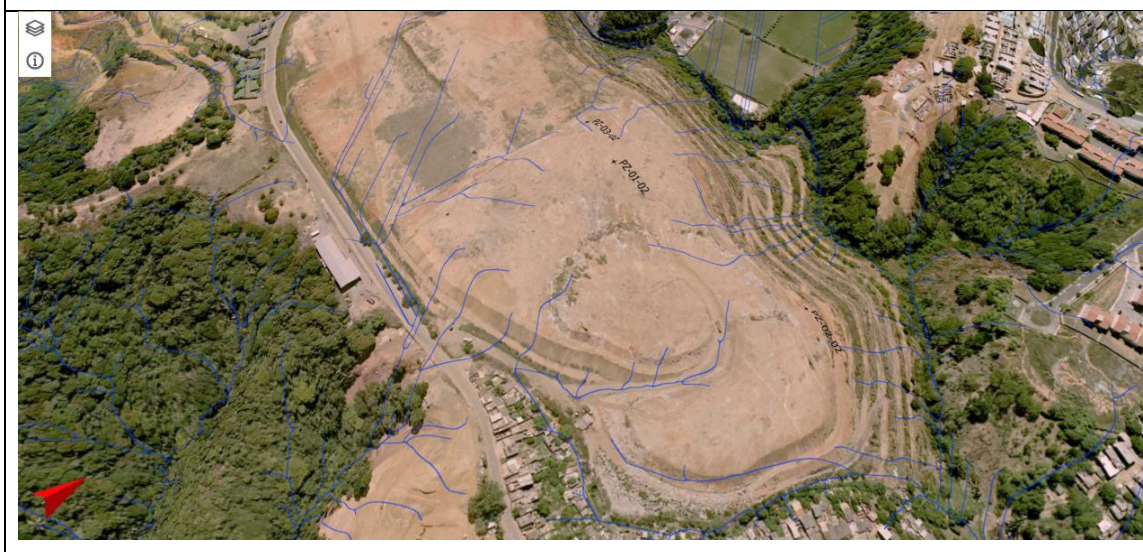
Figura 39– Vista aérea da localização dos Piezômetros sobre imagem do ano de 2006.
