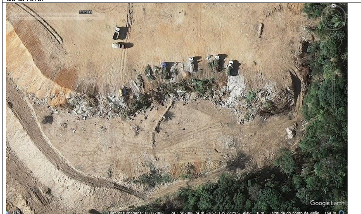
Figura 30 – Detalhes de indícios de lançamento de resíduos sólidos da construção civil e podas de árvore.
