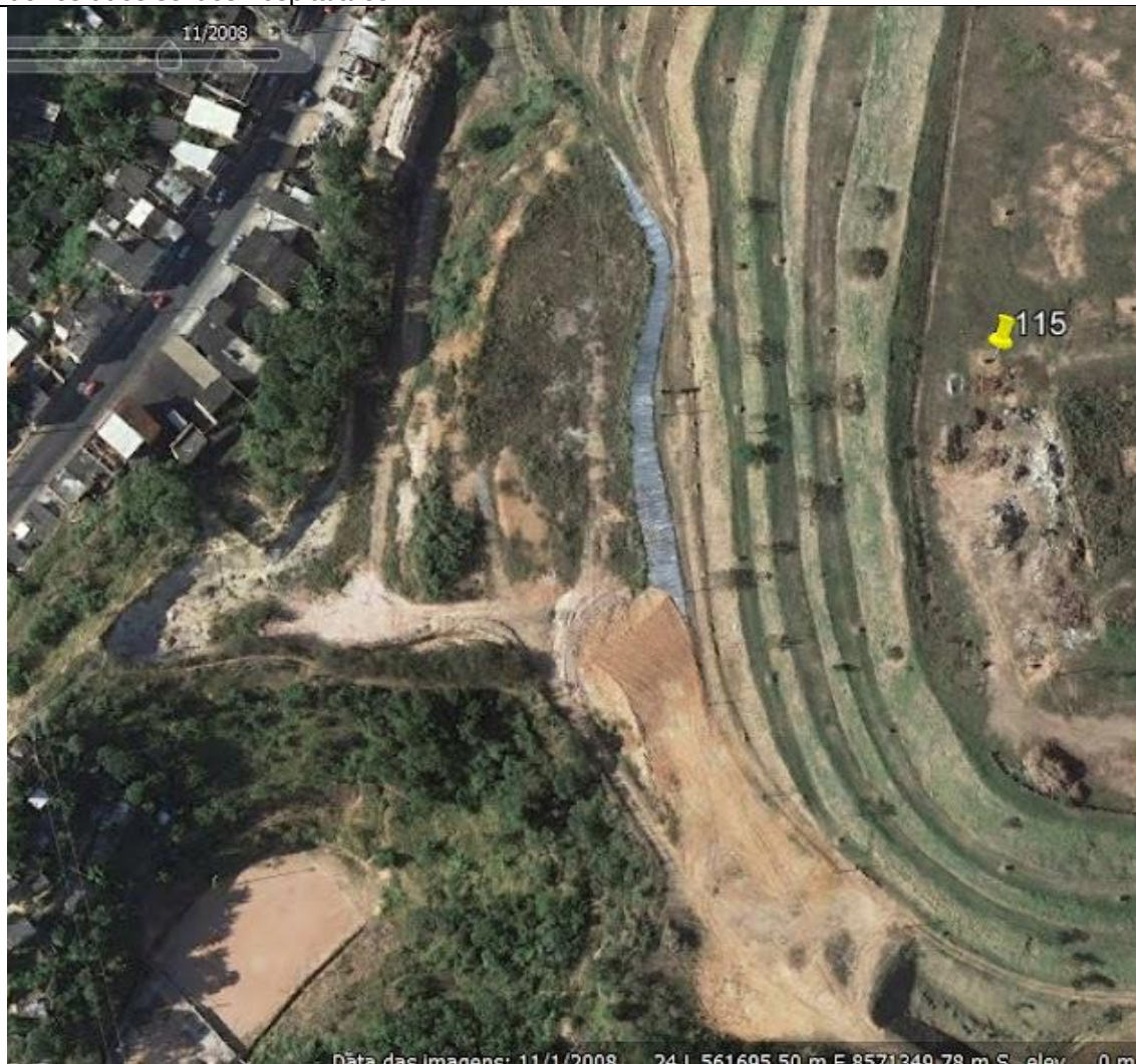
Figura 26– Geomanta recoberta por material areno argiloso, sobre suposta célula de disposição de resíduos sólidos hospitalares.
