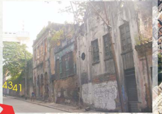
Imóvel nº 41 (Edifício da Nova Corbelha) Imóvel nº 43 (Muro subestação da coelha)
