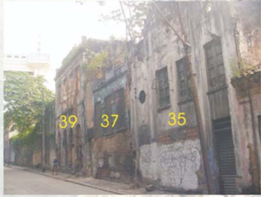
Imóvel nº 35 (Depósito Somo Ferragens) Imóveis em ruína nº 37-39 (Programa Rememorar II)
