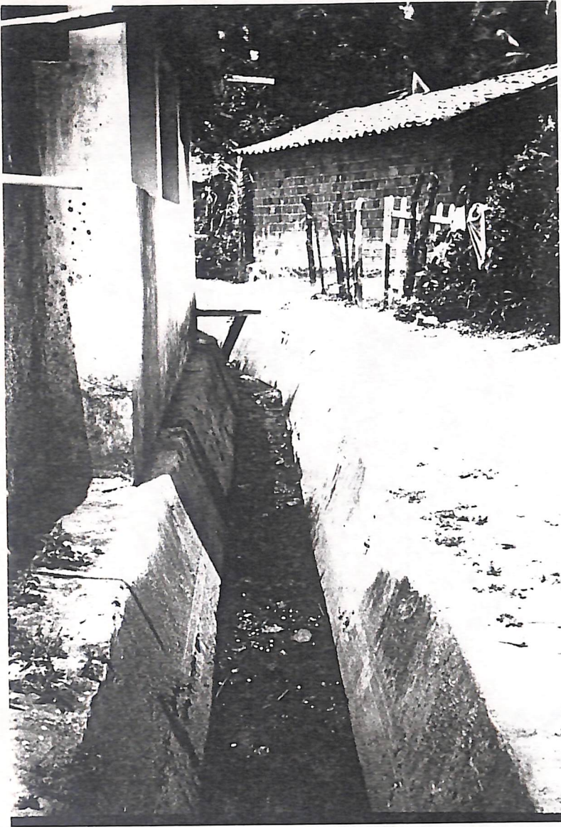
VALAS DE DRENAGEM
