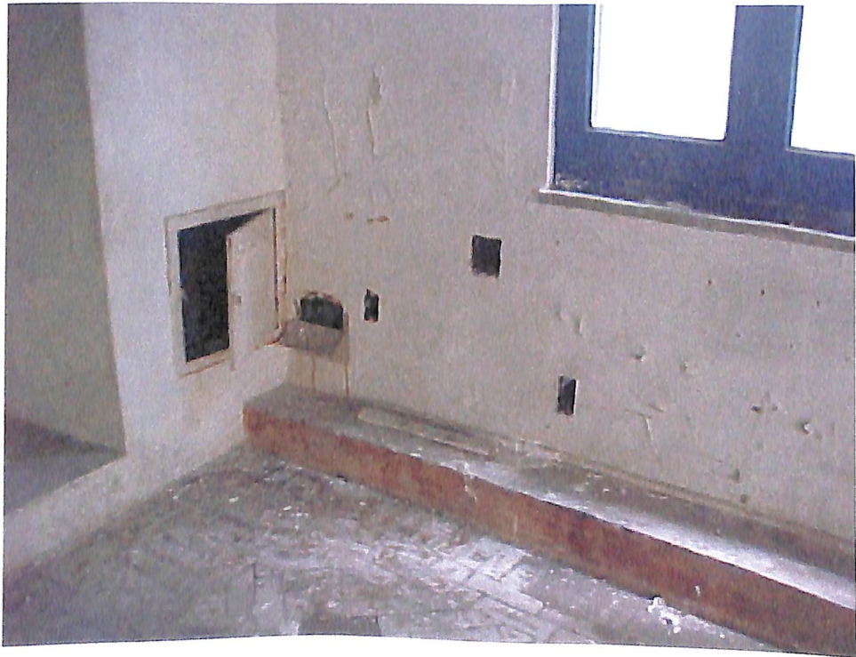
REVESTIMENTOS C/ INFILTRAÇÃO
