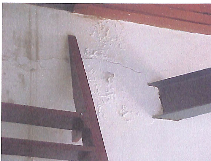
VIGA “I” NA CASA DE MÁQUINAS
