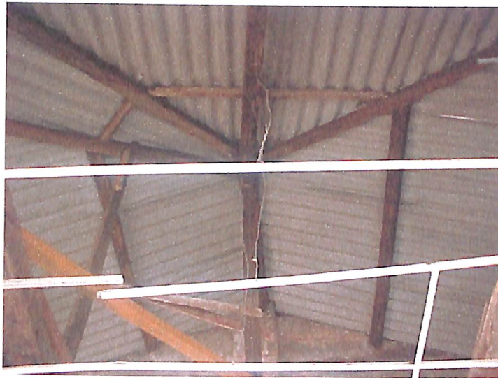
MADEIRAMENTO E COBERTURA
