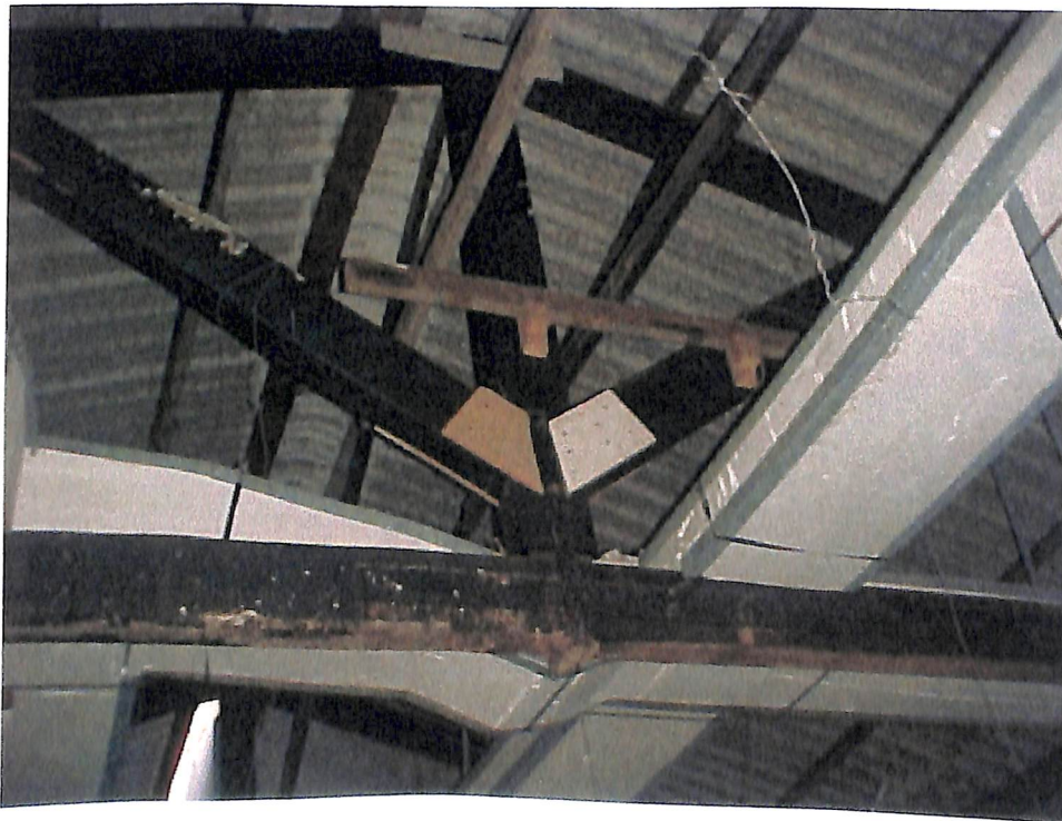
ESTRUTURA DE MADEIRA DO TELHADO
