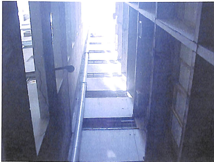
POÇO DE ILUMINAÇÃO E VENTILAÇÃO
