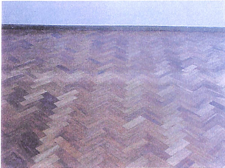
REVESTIMENTO E PISO
