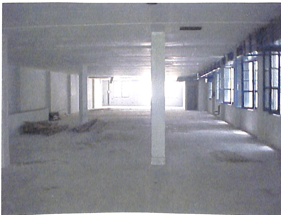
PAVIMENTO C/ FORRO DE GESSO
