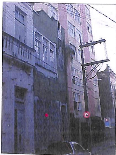
Rua Areial de Baixo nº23 Imóvel 16
