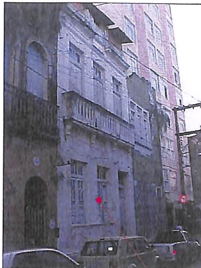
Rua Areial de Baixo nº25 Imóvel 15
