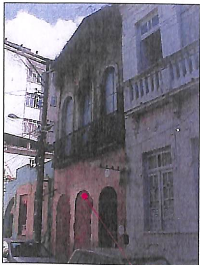
Rua Areial de Baixo nº27 Imóvel 07
