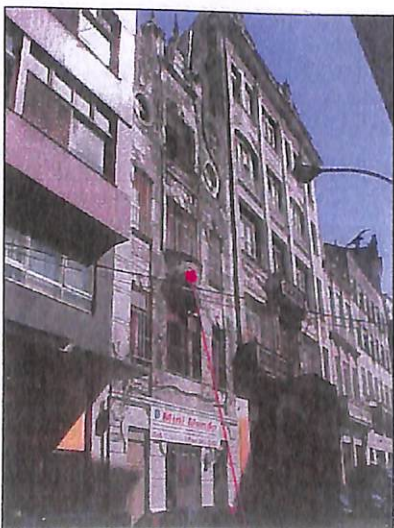
Rua Guindaste dos Padres s/n Imóvel 23
