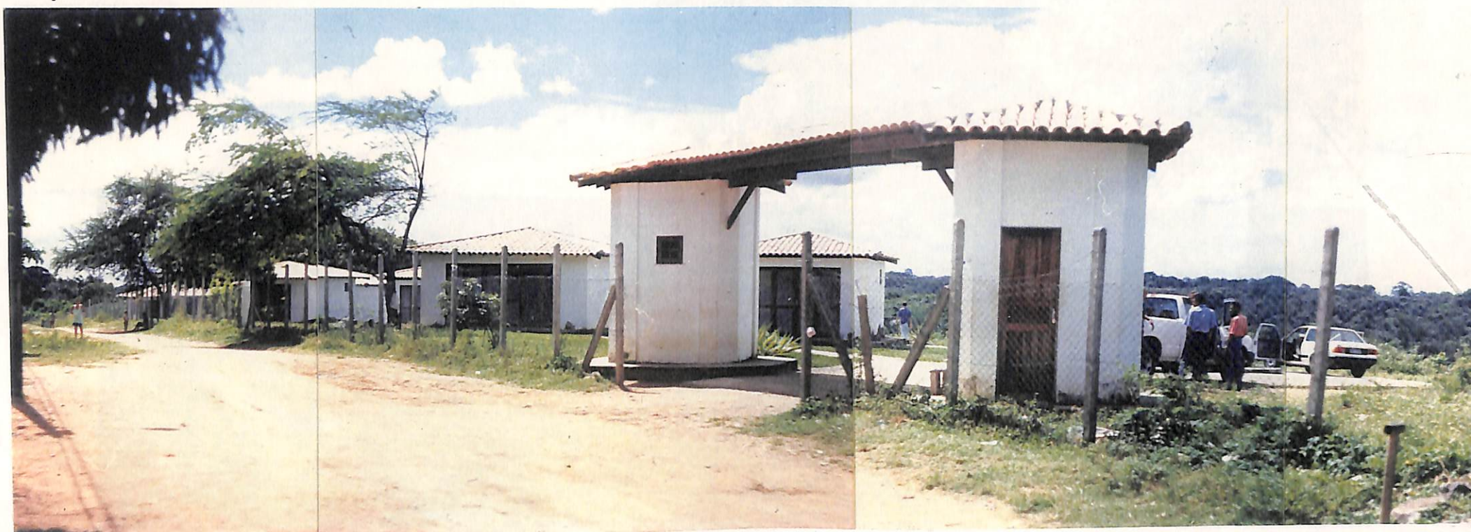
Guarita principal de acesso aos módulos da administração - platô e Ilha Amarela
