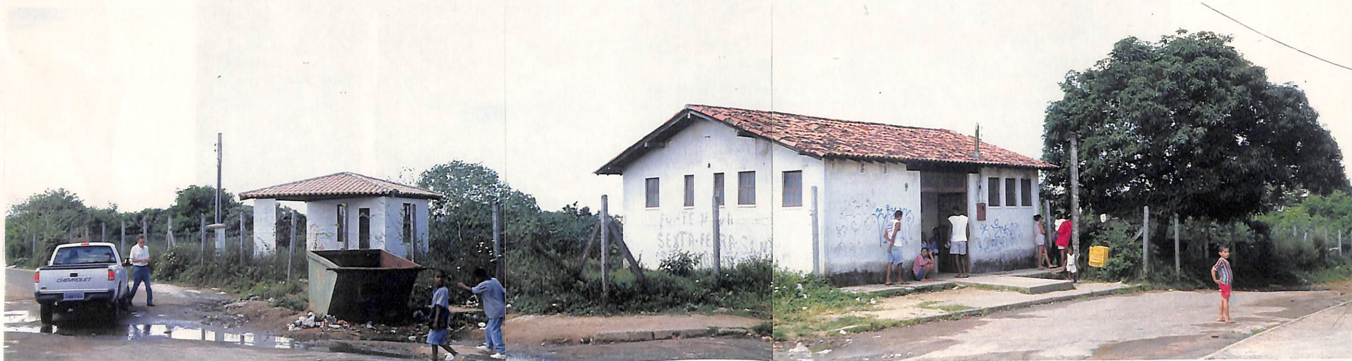
Posto de Saúde e guarita de aos módulos da Administração - platô em Ilha Amarela.
