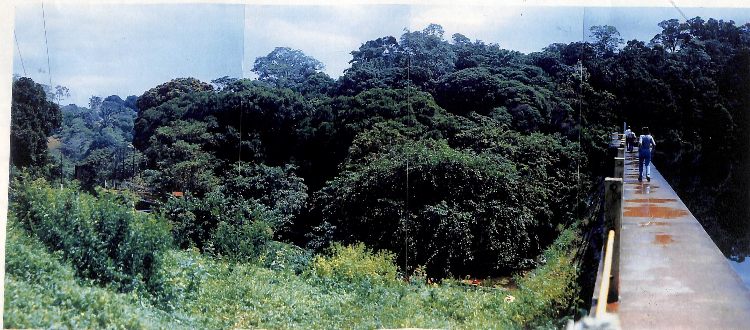
Barragem do Cobre
