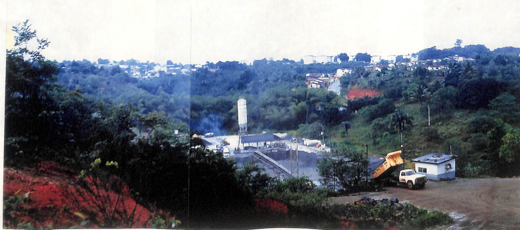
Vista das instalações da Pedreira Civil
