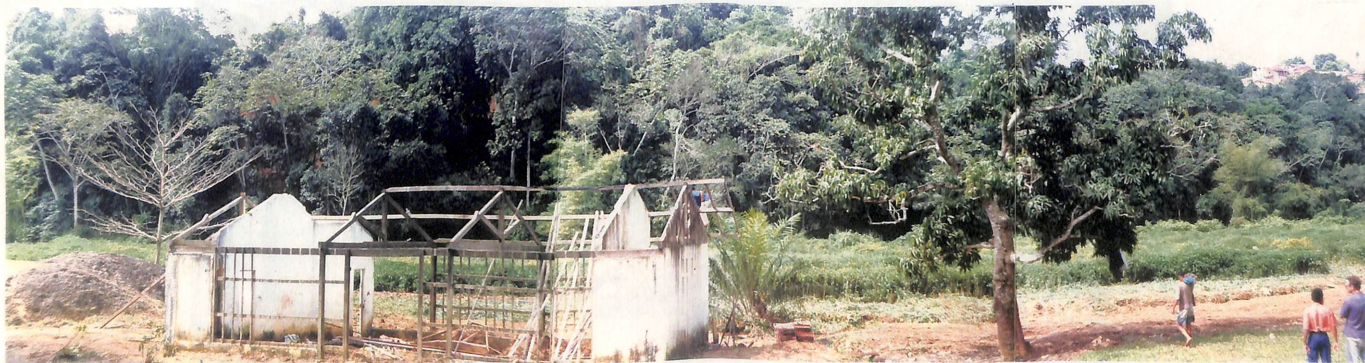
Demolição para reforma geral da Casa de Apoio aos Cultos
