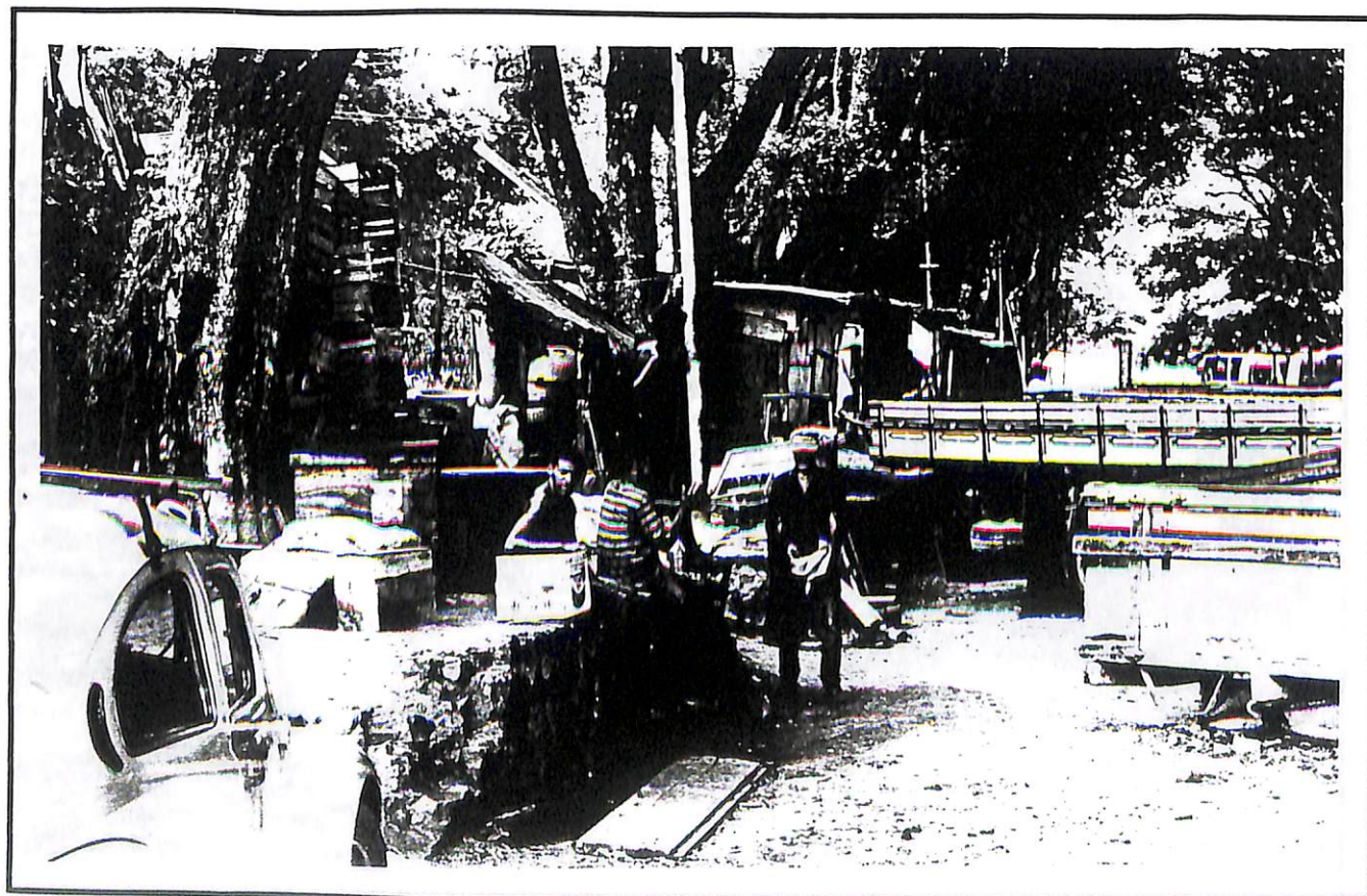
FOTO 06 - Vista da ocupação indevida na área.
