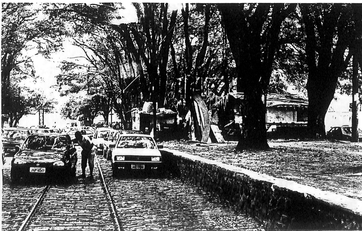
FOTO 02 - Vista da Pista Interna da Praça, mostrando a degradação do local.
