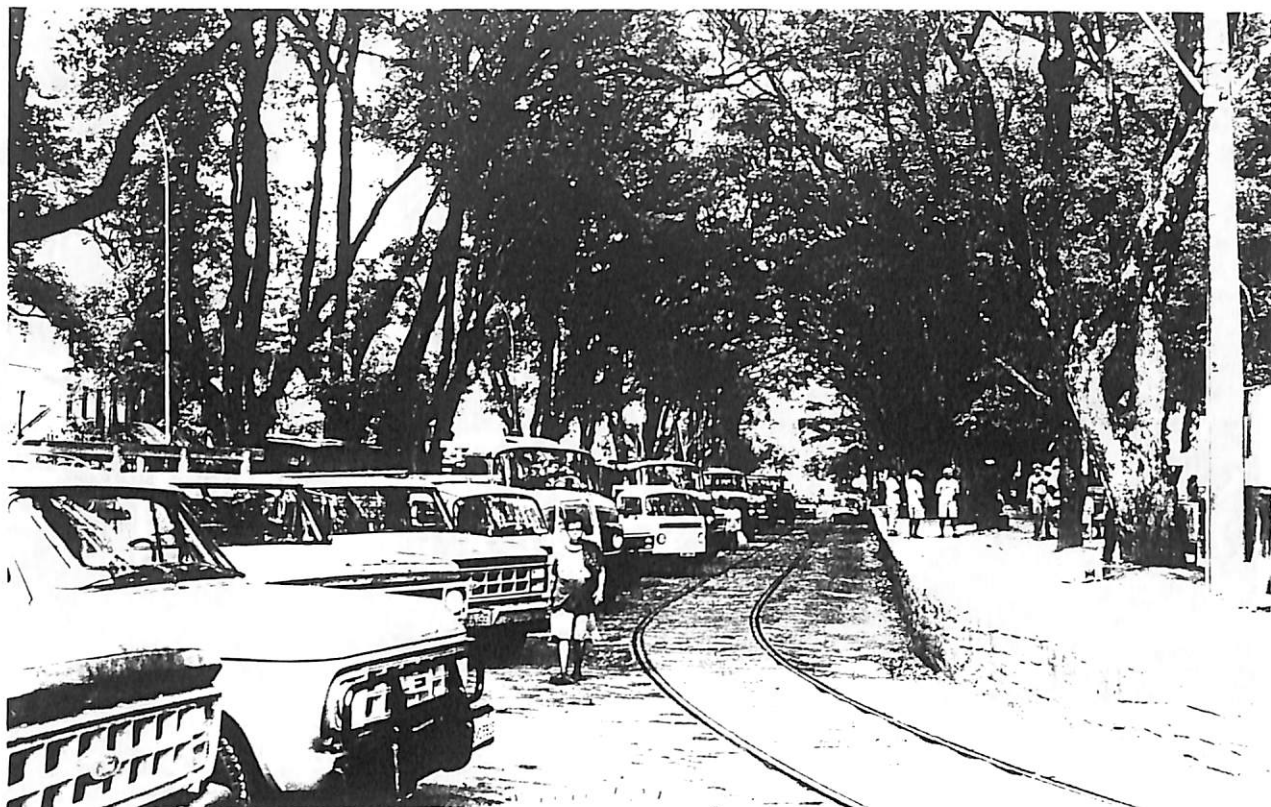
FOTO 01 - Vista da calçada do Mercado do Ouro.
