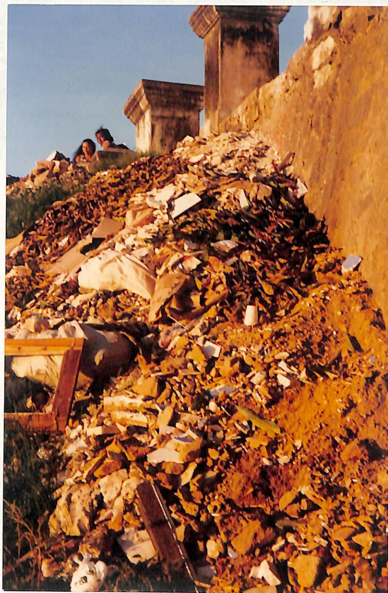
Vista do 2º nível do mirante servindo de depósito de entulho
