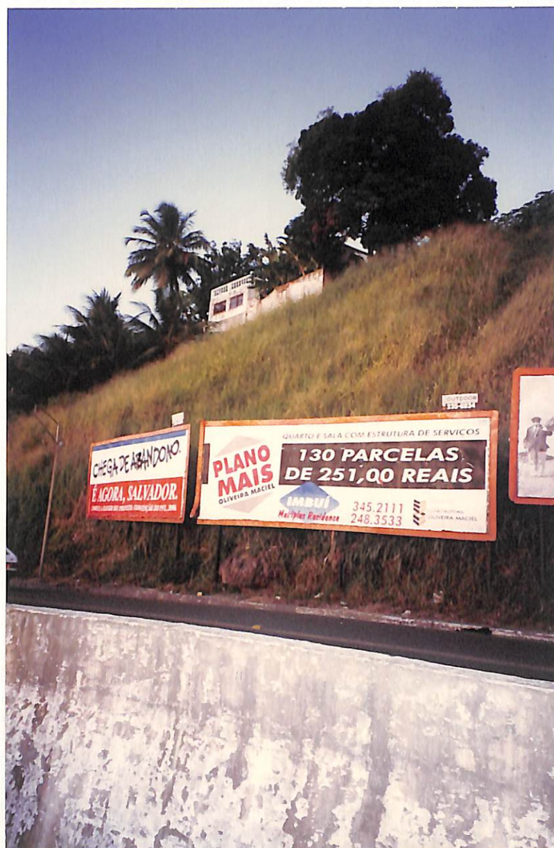
Vista parcial da encosta
