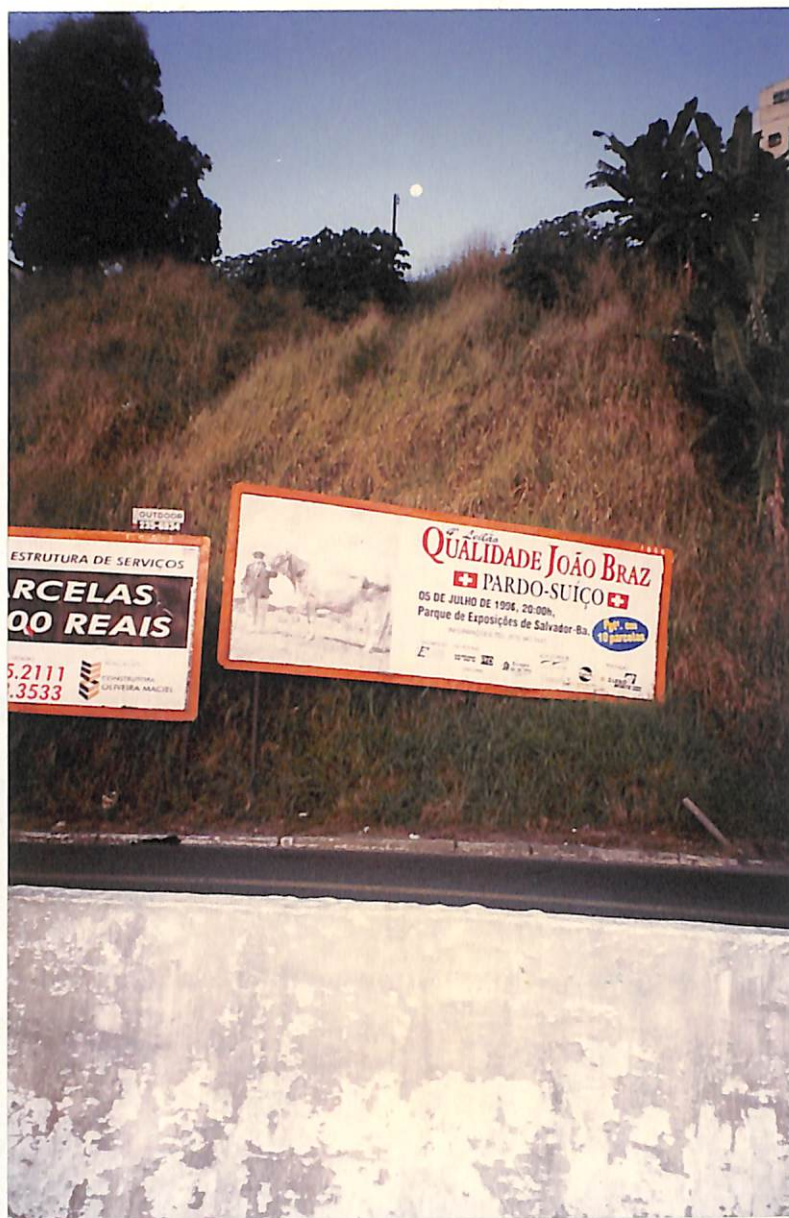
Vista parcial da encosta
