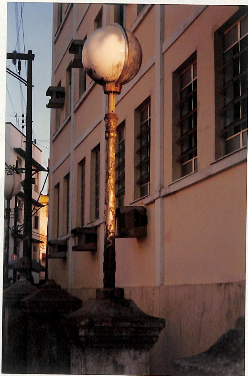
Detalhe de luminária
