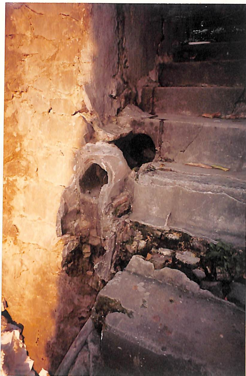
Detalhe de tubu- lação de águas pluviais - arre- bentada
